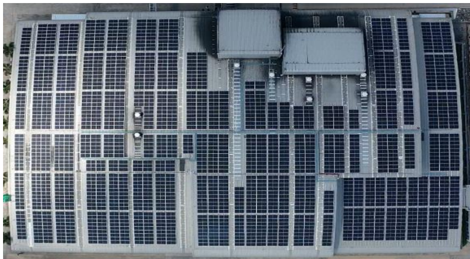
รูปภาพที่ 36 ระบบเซลล์สุริยะที่ติดตั้งบนหลังคาโครงการที่ 1
