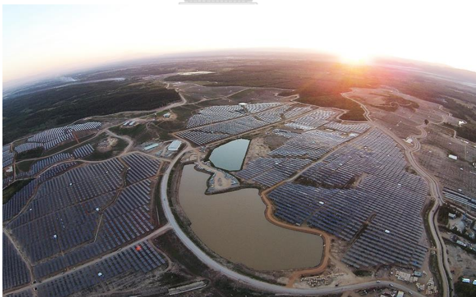
รูปที่ 1 โซลาร์ฟาร์ม ขนาดกำลังติดตั้ง 128.396 MWp (90 MWh) [1]
