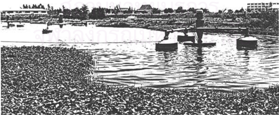
รูปที่ 4 บ่อบำบัดน้ำเสียรวมภายในสวนอุตสาหกรรม โรจนะ
