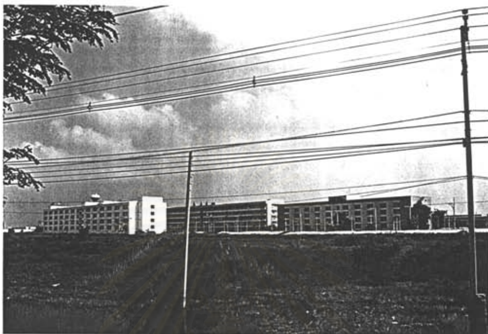
รูปที่ 1 หอพักของสวนอุตสาหกรรมโรจนะ 3 อาคาร (บริเวณด้านหน้า)
