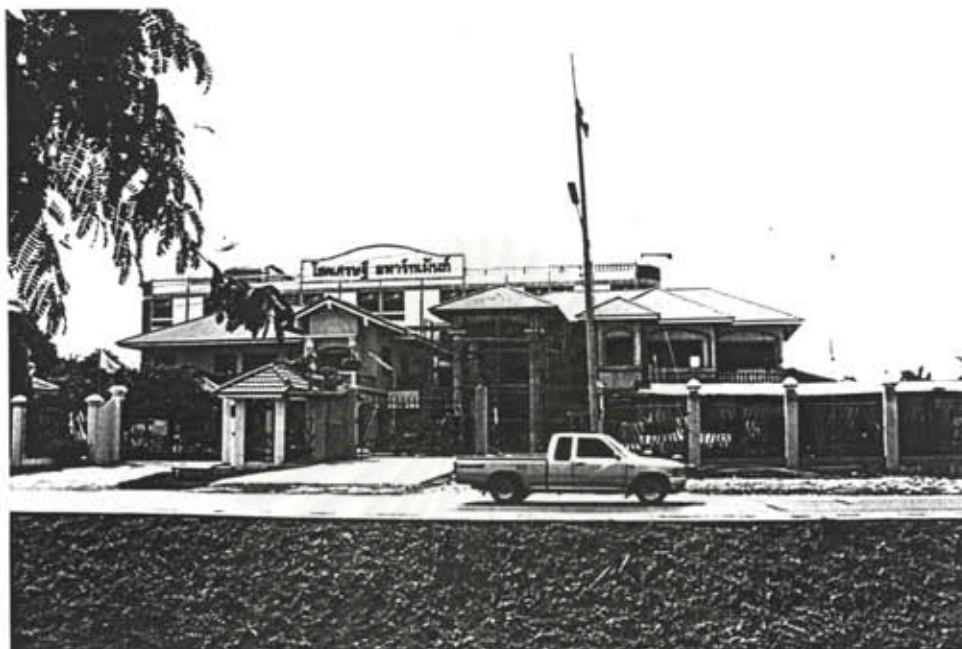
รูปที่ 23 โซคเสรมฐือพาร์ทเมนท์ (ในตัวเมือง) ซึ่งมีการก่อสร้างอาคารเพิ่มเติมรองรับการขยายตัวของแรงงาน
