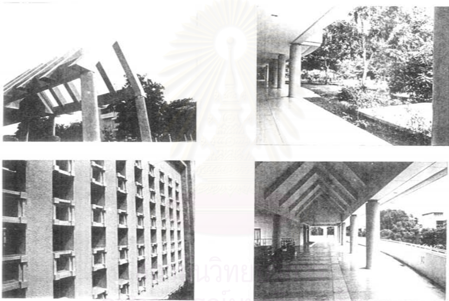
รูป 3.26 ลักษณะโครงฉั้วกันแนวเข้า การยกใต้ถุน การเจาะช่อง และระเบียบบริเวณชั้น 2
