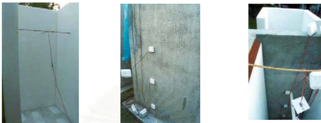
รูปที่ 3.16 แสดงการติดตั้งสายสัญญาณในห้องโฝม และบ่อทดลอง
