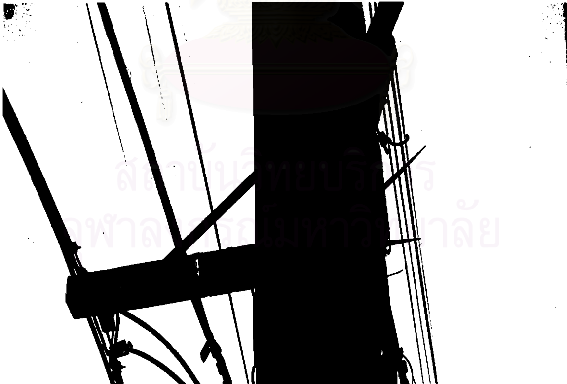
รูปที่ 1.2 ความเสียหายคอนไม้แขวนเคเบิล (1)
