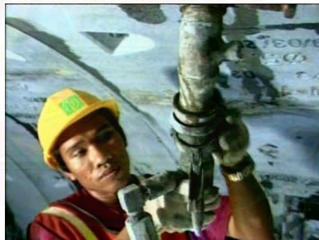
รูปที่ 3.12 การอุดช่องว่างรอบคาน้ำอุโมงค์ (Metropolitan Rapid Transit Authority [MRTA], 2546)
