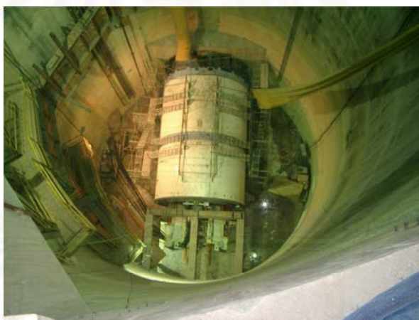
รูปที่ 5.5 ปล่องขนถ่ายดินหลักที่ต้นอุโมงค์โครงการกรณีศึกษา
