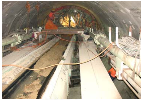
รูปที่ 3.7 สายพานลำเลียงดิน (สำนักการระบายน้ำ, 2548)
