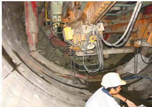
รูปที่ 3.8 เครื่องค้ำยันดาดผนังอุโมงค์ (สำนักการระบายน้ำ, 2548)
