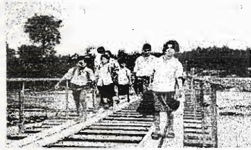
ซ่อมแซมสะพานที่ถูกน้ำท่วม
