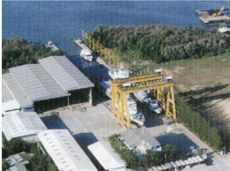
รูปที่ ๓3 ระบบ Mobile Crane ของอู่เรือ บริษัท มาร์ชั่น จำกัด
