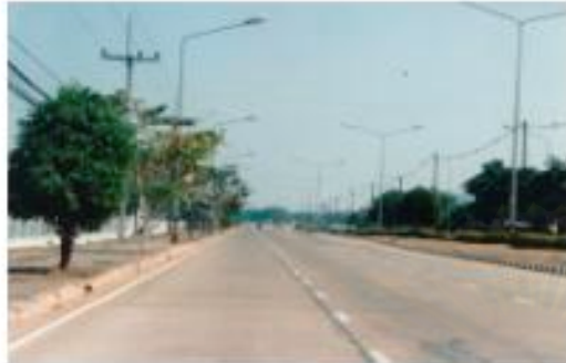
สภาพก่อนการปรับปรุง
