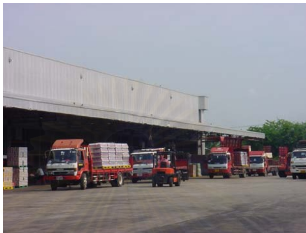
รูปที่ 3.8 บริเวณลานขึ้นน้ำในโรงงานรังสิต
