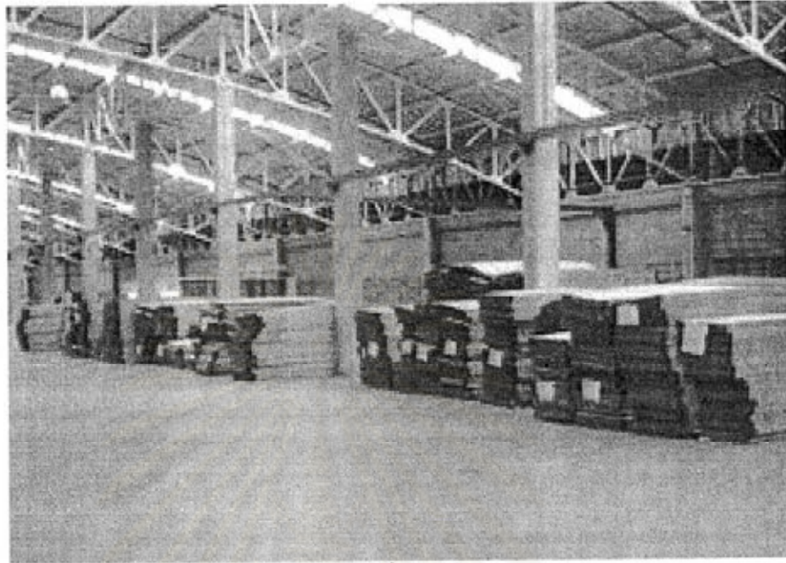
ภาพสถานที่ก่อนการก่อสร้าง
