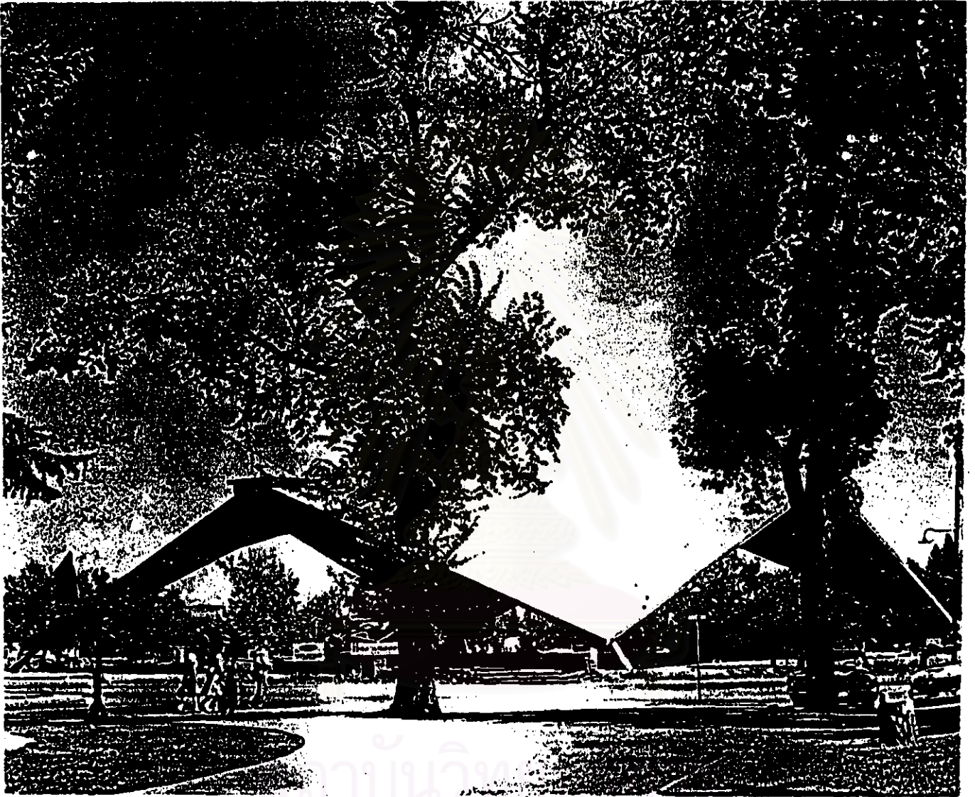
รูปที่ 1 International Center ,Broadmoor Hotel, Colorado Springs, Colorado
