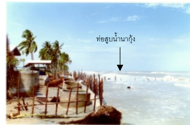
นาุ้งบริเวณแหลมตะลุมพุกที่ถูกกีดเซาะ
