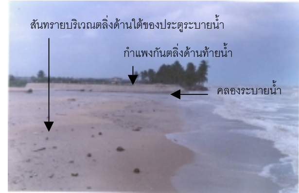
ประตูระบายน้ำบ้านหัวป่า
