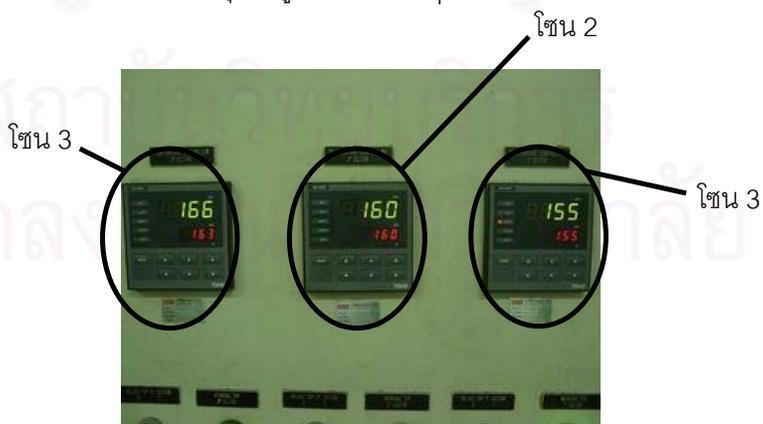
รูปที่ 7. ชุดตั้งค่าและแสดงอุณหภูมิ
