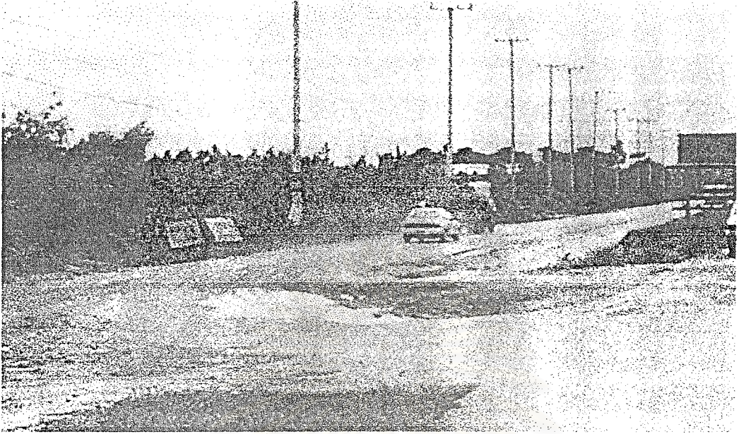
รูปที่ 3.9 ประชาชนลอบใช้เส้นทางที่อยู่ในระหว่างการก่อสร้าง
