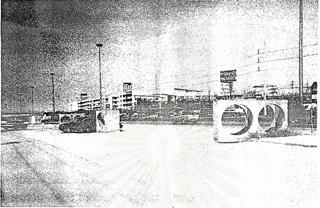
รูปที่ 3.5 ผู้รับจ้างนำวัสดุ อุปกรณ์หรือสิ่งของมากีดขวางใกล้ทางจราจร
