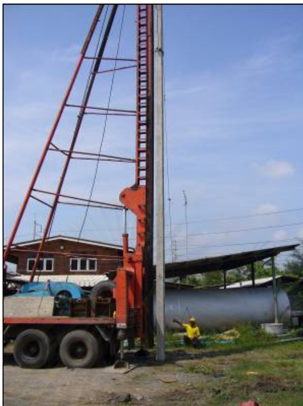
รูป 3.21 เสาเข็มต้นที่ 7 ความยาว 12 เมตร
