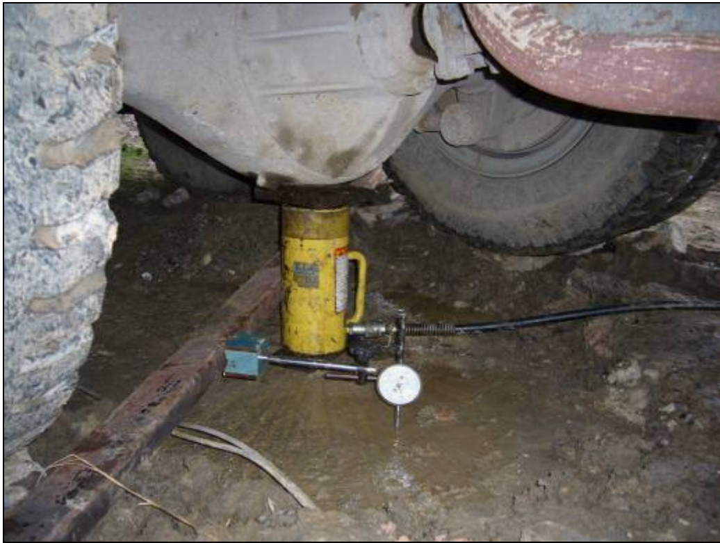
รูป ผ5 ลักษณะการติดตั้งแม่แรงกดเสาเข็ม และ เภจวัคระยะการทรุดตัว
