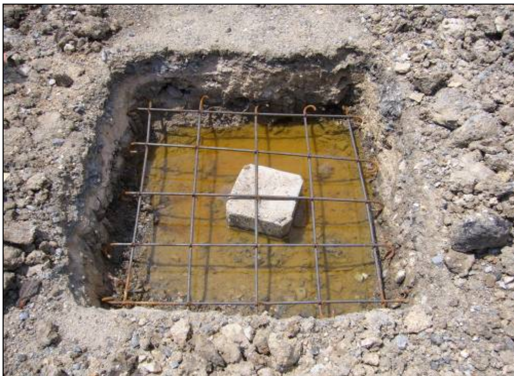
รูปที่ 3.26 หลังจากขุดหลุมแล้วนำเหล็กตะแกรงวางบนหัวเสาเข็มทุกหลุม
