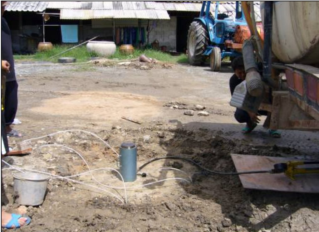
รูปที่ 3.33 หลังจากกลบดินแล้ว นำแม่แรงไฮดรอลิก (Hydraulic Jack) มาวางที่ศูนย์กลางของแผ่นพื้นคอนกรีต
