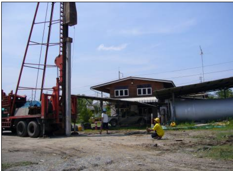
รูป 3.23 การตรวจสอบความเอียง โดยลูกค้ำก่อนตอกเสาเข็ม
