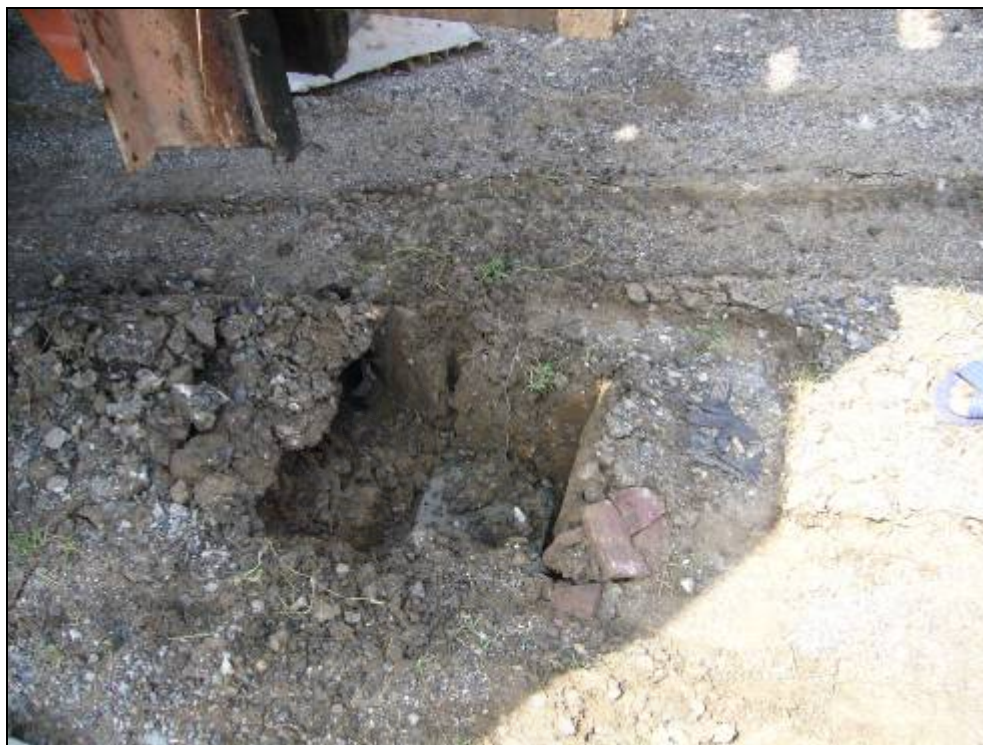
รูป 3.25 หลังจากตอกเสาเข็มถึงระดับดินแล้วทำการส่งหัวเสาเข็มลงไปอีกประมาณ 35 เซนติเมตร
