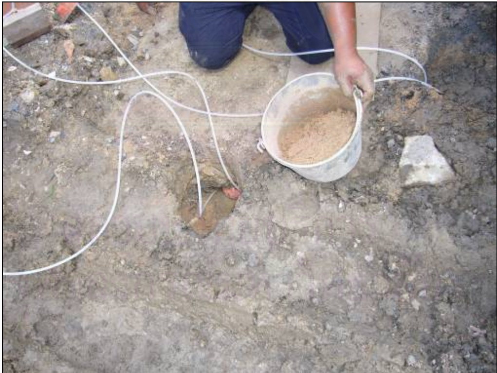
รูปที่ 3.32 ฟังลูกบอลสำหรับวัดแรงดัน (Pressure) เข้าไปในแผ่นพื้นคอนกรีต
