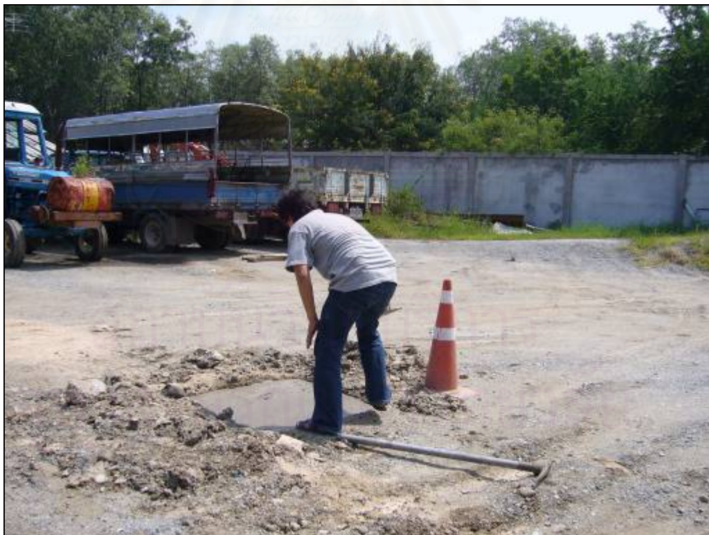
รูปที่ 3.29 ทำการปรับแต่งหน้าคอนกรีตให้เรียบหลังจากเทคอนกรีตได้ระดับความหนาแล้ว
