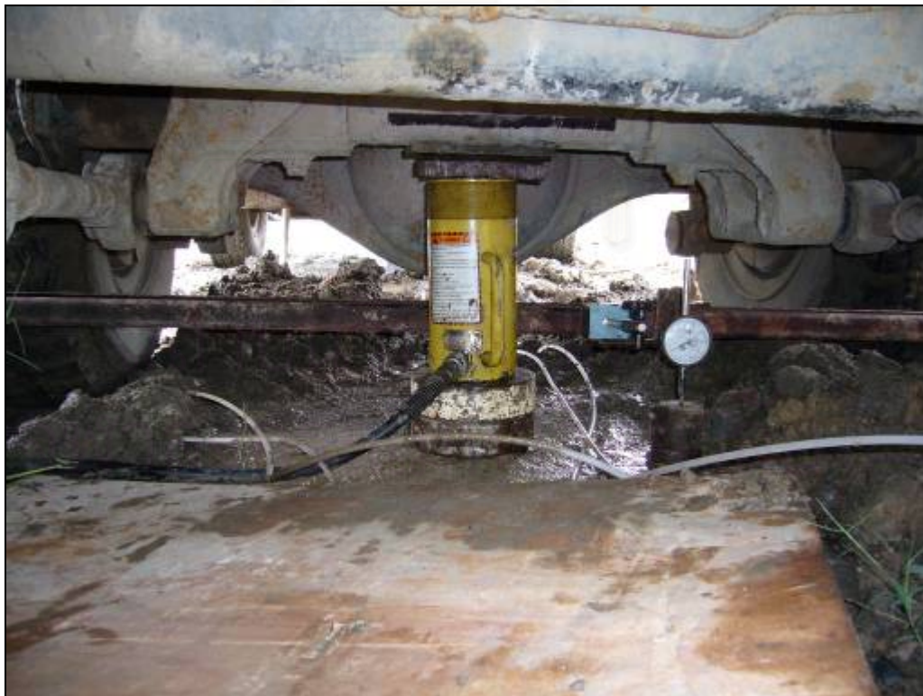
รูป ผ2 การทดสอบเสาเข็มรับน้ำหนักร่วมกับแผ่นคอนกรีต
