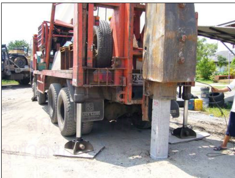
รูป 3.24 การตอกเสาเข็มโดยใช้รถป็นจันในการตอก
