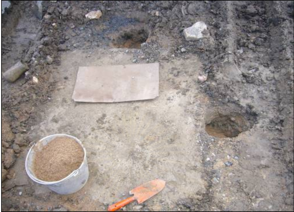
รูปที่ 3.31 จุดหลุมด้านข้าง 2 หลุมลึกลงไปประมาณ 35 เซนติเมตร ทั้งด้านแกน X และ แกน Y
