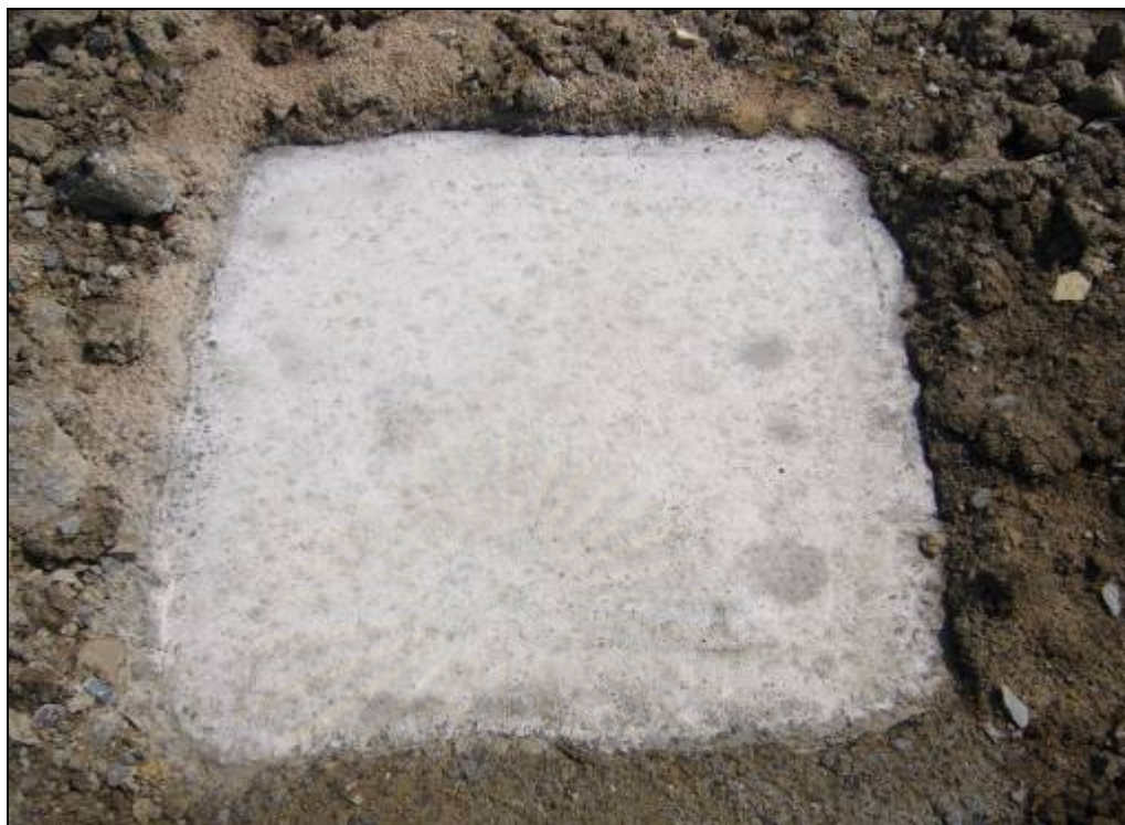
รูปที่ 3.30 ทำการบ่มคอนกรีตด้วยน้ำแล้วปล่อยให้คอนกรีตรับกำลังได้สูงสุดประมาณ 28 วัน
