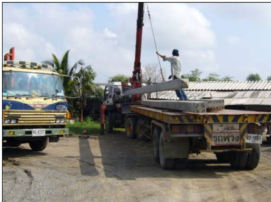
รูป 3.10 การขนส่งเสาเข็มด้วยรถเทเลอร์หางยาว
