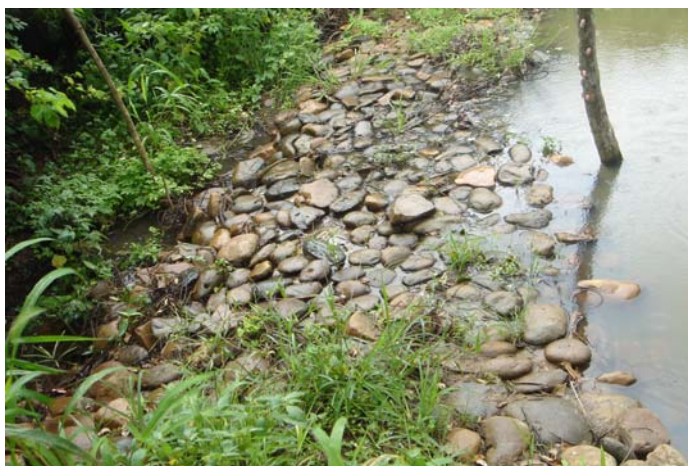
รูปที่ ค - 5 แสดงฝ่ายผสมผสานแบบหินทิ้ง
