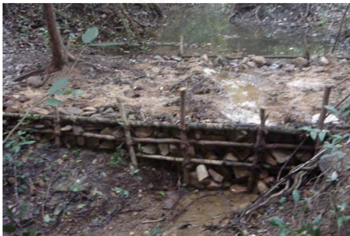
รูปที่ ค - 1 แสดงภาพฝายผสมผสานแบบคอกหมู
