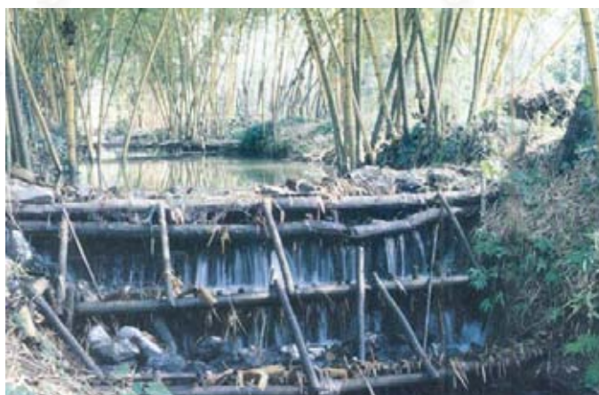
รูปที่ ค - 2 แสดงภาพฝายผสมผสานแบบไม้ไผ่
