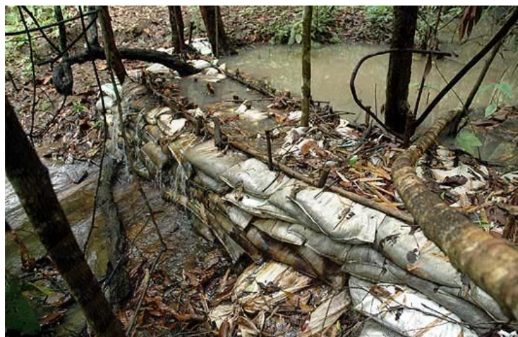
รูปที่ ค - 3 แสดงภาพฝ่ายผสมผสานแบบกระสอบ
