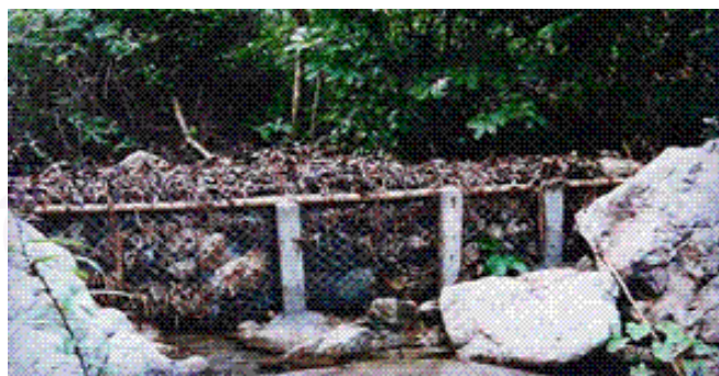
รูปที่ ค - 4 แสดงฝ่ายผสมผสานแบบลวดตาข่าย
