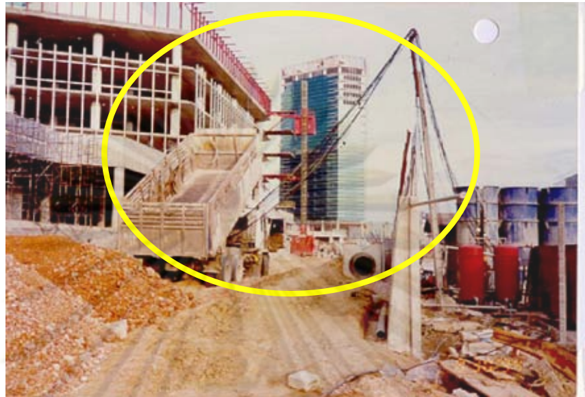
รูปที่ 2.4 ภาพถ่ายแสดงอุบัติเหตุในงานก่อสร้างเนื่องจากรถบรรทุกติดสายไฟฟ้า
