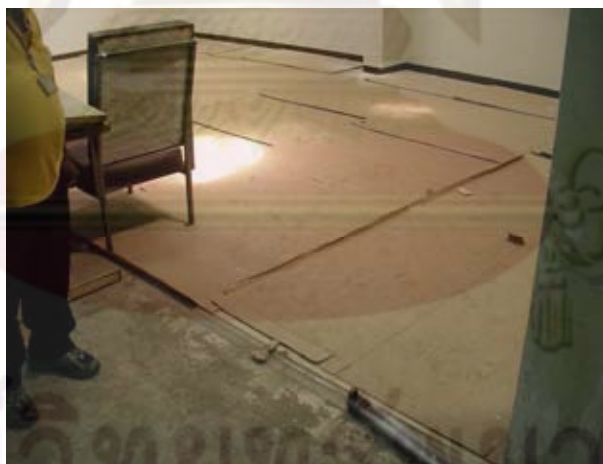
ภาพที่ 3-6 การปูไม้อัดเพื่อป้องกันผิวพื้นเดิม
