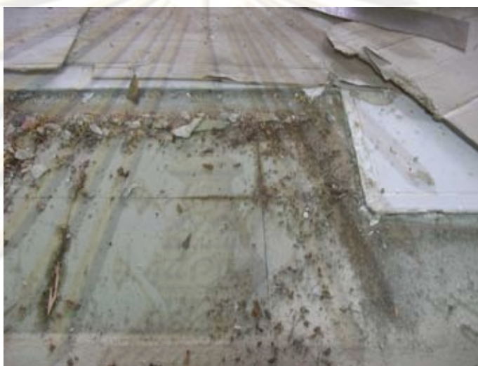
ภาพที่ 3-5 การซ่อมแซมผิวพื้นเดิมเมื่อรื้อถอนผนัง
