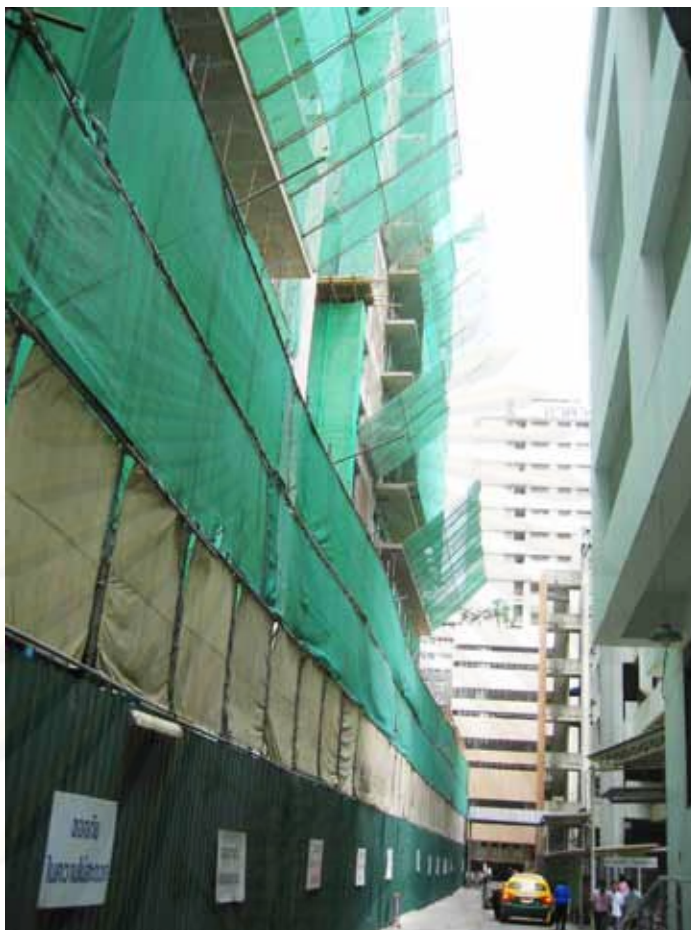
รูปที่ 4.2.2 ภาพการติดตั้งตาข่ายกันเศษวัสดุ
