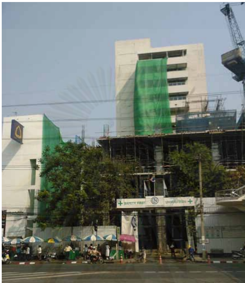
รูปที่ 4.4.4 ภาพการป้องกันอาคารข้างเคียง
