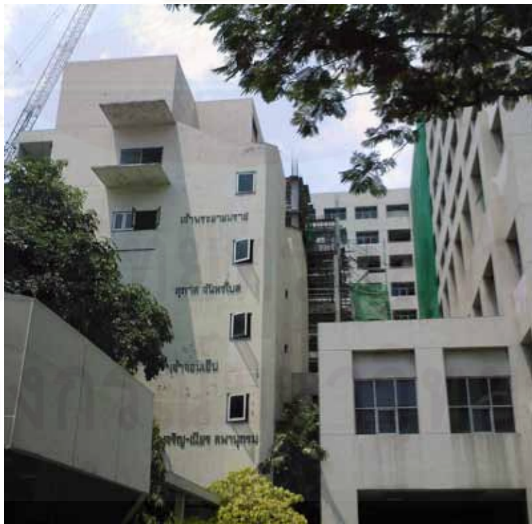
รูปที่ 4.4.3 ภาพการป้องกันอาคารข้างเคียง
