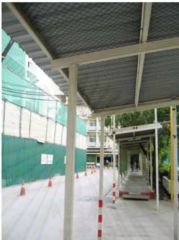
รูปที่ 4.5.5 ภาพทางเดินปลอดภัย
