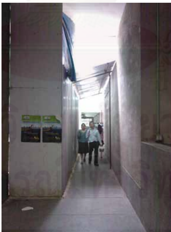
รูปที่ 4.1.4 การจัดเตรียมทางเบี่ยงและหลังคาป้องกันเศษวัสดุ
