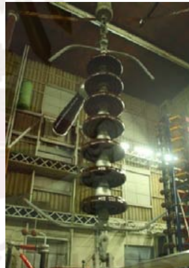
(ง) อาร์คซึ่งฮอรั่นแบบแบ่งกลม-แบ่งกลม ติดตั้งกับลูกถ้วยแขวนจำนวน 7 ลูก
