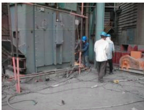
แผนภาพที่ 4.25 แสดงการติดตั้งฐานกะพ้อ
