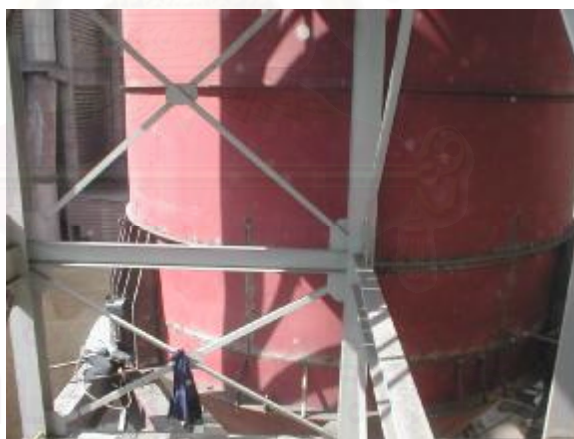
แผนภาพที่ 4.35 แสดงการเคลือบสีรองพื้นแล้ว
