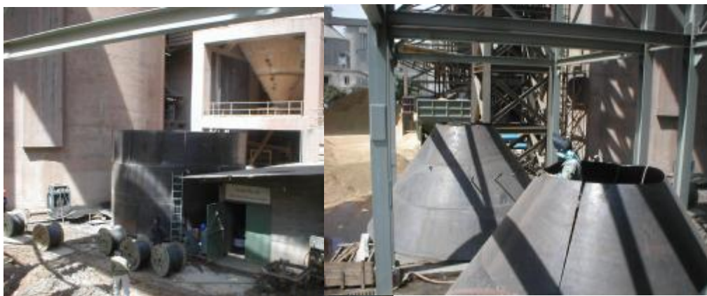
แผนภาพที่ 4.26 แสดงการประกอบถังกับกรวย
