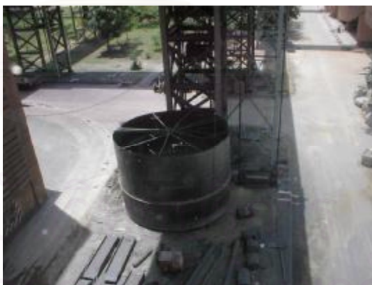
แผนภาพที่ 4.31 แสดงไซโลเตรียมพ่นสีรองพื้น
