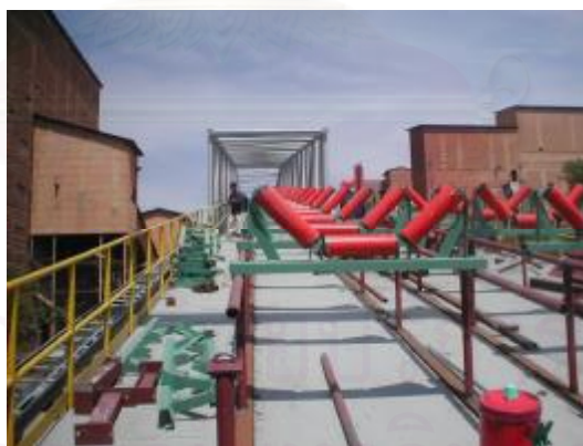
แผนภาพที่ 4.27 แสดงการติดตั้งลูกกลิ้งและตัวรับลูกกลิ้ง
