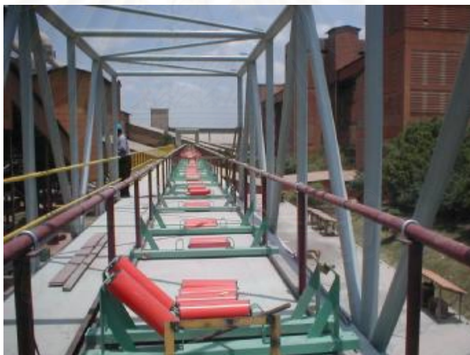
แผนภาพที่ 4.23 แสดงการติดตั้งโครงสายพาน
