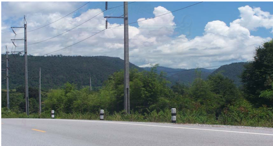
(ข) ภาพถ่ายจากสถานที่จริง
