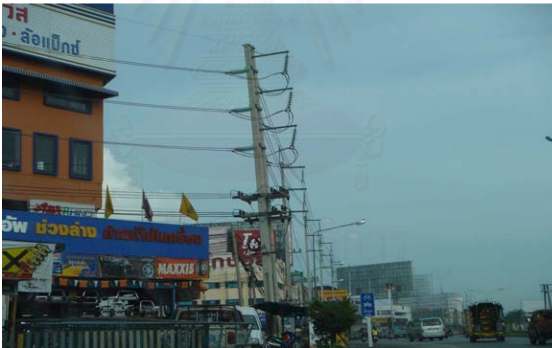
(ข) ภาพถ่ายจากสถานที่จริง
