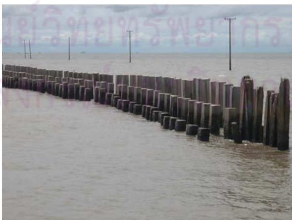
ค) เสาคอนกรีตรูปสามเหลี่ยมแบบ 3 แถว ต.แหลมฟ้าผ่า อ.พระสมุทรเจดีย์ จ.สมุทรปราการ รูปที่ 1-1 ตัวอย่างเขื่อนกันคลื่นแบบเสาเข็มในประเทศไทย
