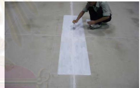
ฉ) ทาสีพื้นที่สำหรับติดตั้งแบบจำลอง
