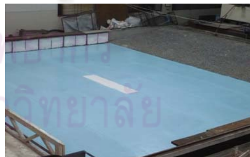
ซ) แอ่งคลื่นหลังปรับปรุงเสร็จ
