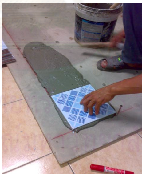
รูปที่ 5.12 การเริ่มต้นปูกระเบื้องส่วนที่ไม่ต้องทำการตัด
