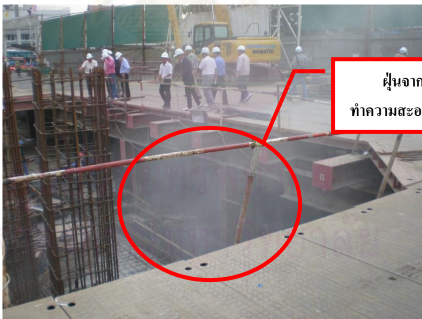
รูปที่ 4.4 ฝุ่นละอองที่เกิดจากการทำความสะอาดไม้แบบเพื่อเตรียมเทคอนกรีตฐานรากของอาคาร
