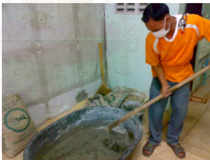
รูปที่ 5.10 การผสมปูนสำหรับปูกระเบื้อง
