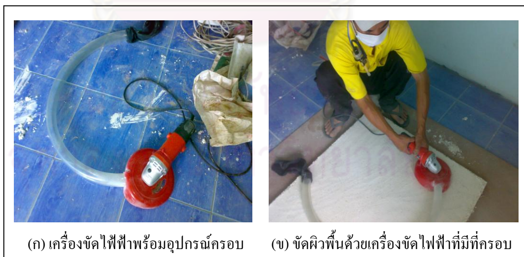
รูปที่ 5.46 เครื่องขัดไฟฟ้าพร้อมอุปกรณ์ครอบใบขัดและการขัดผิวพื้นหินขัดด้วยเครื่องขัดไฟฟ้าที่มีที่ครอบ
