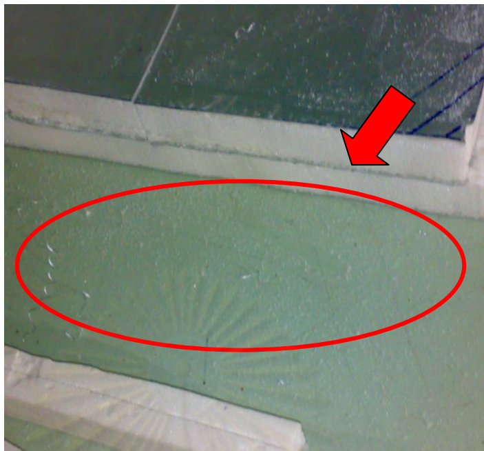
รูปที่ 5.24 เศษวัสดุของฝ้าที่เกิดจากการตัด
