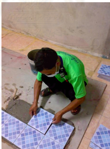
รูปที่ 5.19 การปูกระเบื้องส่วนที่ไม่ต้องทำการตัด
