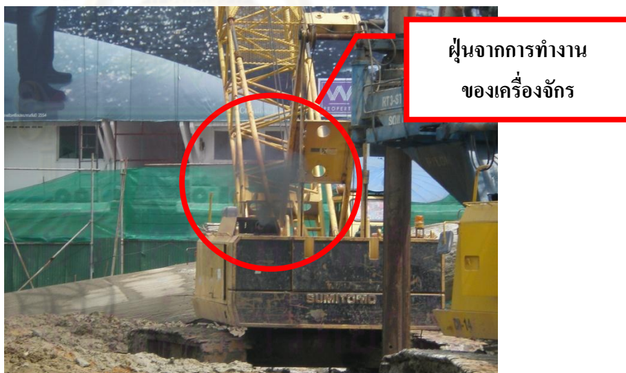
รูปที่ 4.2 การทำงานของเครื่องจักรบริเวณสถานที่ก่อสร้างทำให้เกิดเขม่าควันและฝุ่นละออง
