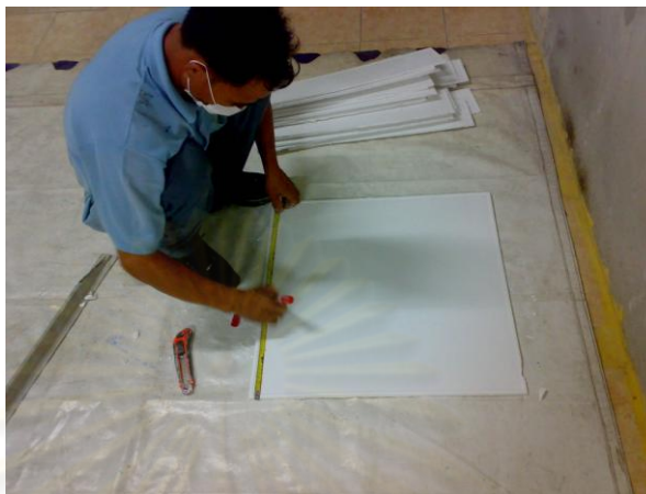
รูปที่ 5.28 การวัดแผ่นฝ้าก่อนทำการตัด
