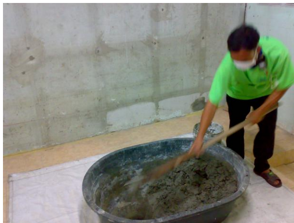
รูปที่ 5.18 การผสมปูนสำหรับปูกระเบื้อง
