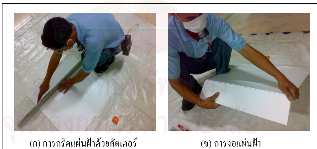
รูปที่ 5.29 การกรีดแผ่นฝ้าด้วยมีดคัตเตอร์และการงอเพื่อหักแผ่นฝ้า
