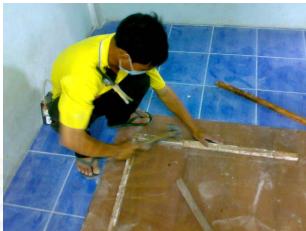
รูปที่ 5.41 การกำหนดขอบของพื้นที่ที่จะทำพื้นปูหินขัด
