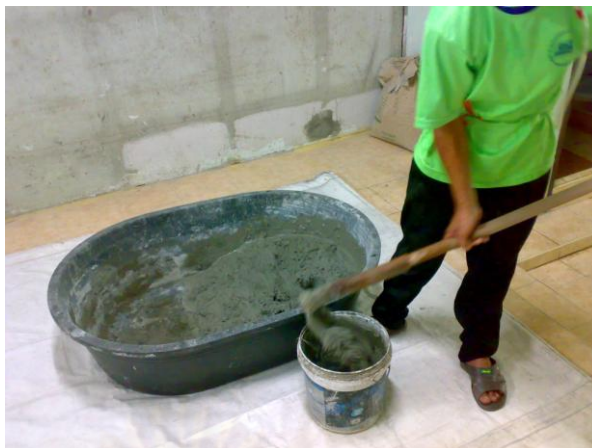
รูปที่ 5.20 การตักปูนใส่ถังเพื่อนำมาใช้ในการปูกระเบื้อง
