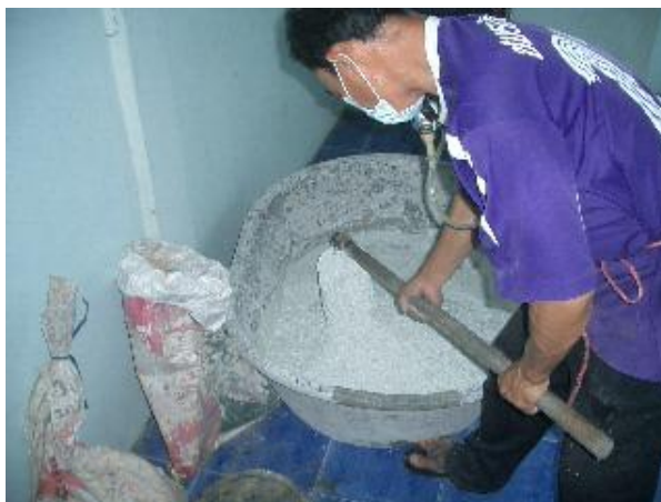
รูปที่ 5.36 การผสมปูนสำหรับปูพื้นหินขัด
