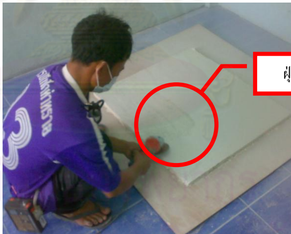
รูปที่ 5.39 การขัดผิวพื้นให้เรียบด้วยเครื่องขัดไฟฟ้า
