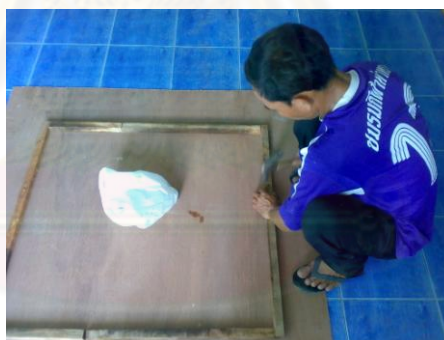
รูปที่ 5.35 การกำหนดขอบของพื้นที่ที่จะทำพื้นปูหินขัด
