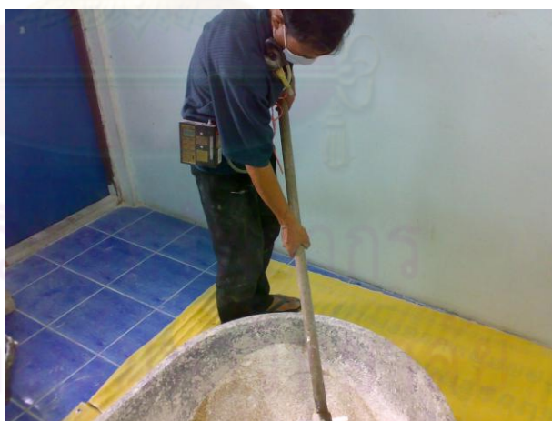
รูปที่ 5.50 การผสมปูนสำหรับปูพื้นหินขัด
