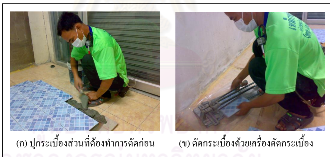
รูปที่ 5.21 การปูกระเบื้องส่วนที่ต้องทำการตัดก่อนและการตัดกระเบื้องด้วยเครื่องตัดกระเบื้อง
