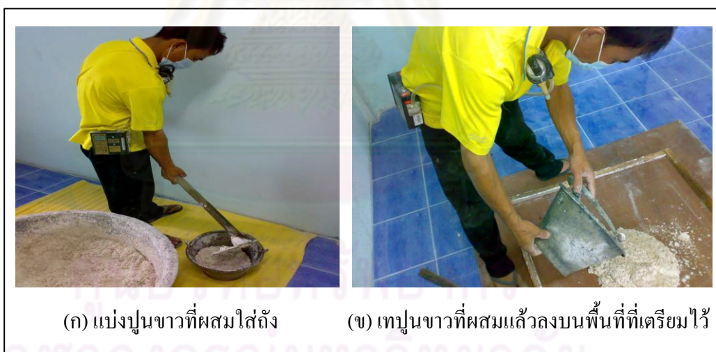
รูปที่ 5.44 การแบ่งปูนขาวที่ผสมใส่ถังและการเทปูนขาวที่ผสมแล้วลงบนพื้นที่ที่เตรียมไว้
