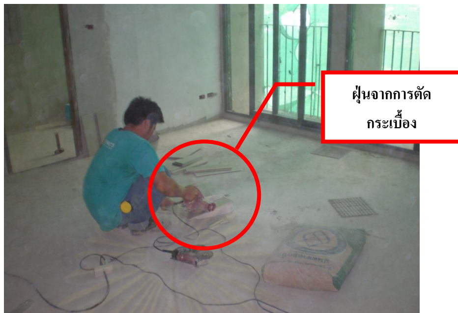
รูปที่ 4.5 การตัดกระเบื้องซึ่งทำให้เกิดฝุ่นละอองจากเศษผงของกระเบื้อง
