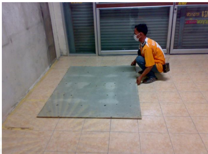
รูปที่ 5.9 การวางแผ่นไม้สำหรับใช้ปูกระเบื้อง
