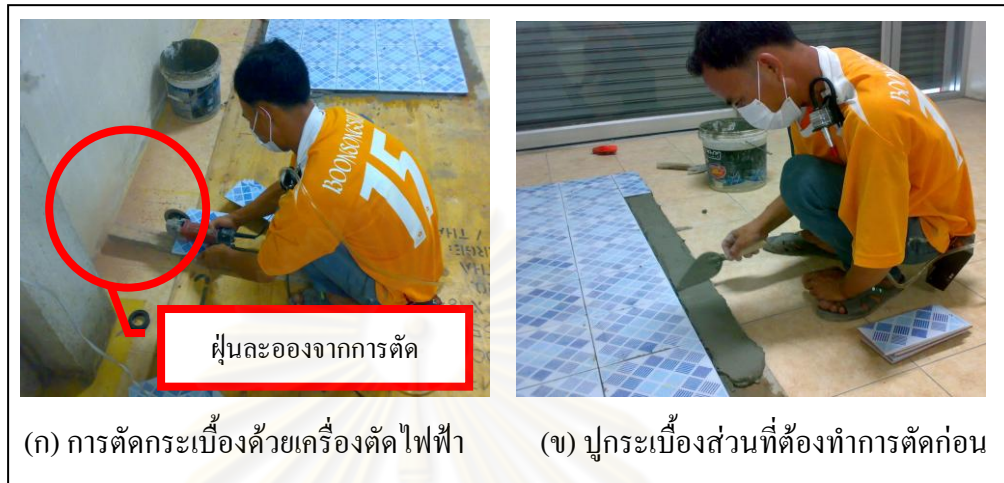
รูปที่ 5.13 การตัดกระเบื้องด้วยเครื่องตัดไฟฟ้าและการปูกระเบื้องส่วนที่ต้องทำการตัดก่อน
