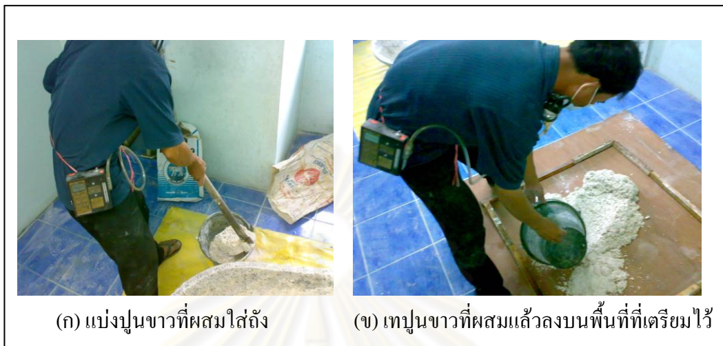
รูปที่ 5.51 แบ่งปูนขาวที่ผสมใส่ถัง และการเทปูนขาวที่ผสมแล้วลงบนพื้นที่ที่เตรียมไว้
