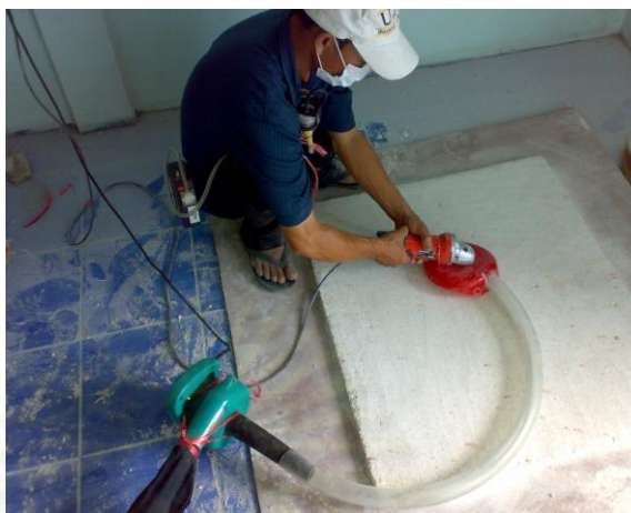
รูปที่ 5.53 การขัดผิวพื้นหินขัดด้วยเครื่องขัดไฟฟ้าที่มีที่ครอบพร้อมเครื่องดูดอากาศ
