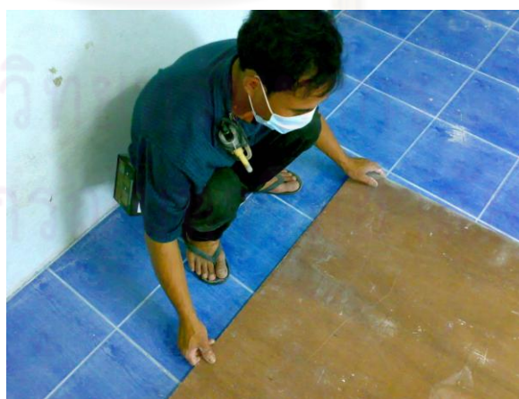
รูปที่ 5.48 การเตรียมแผ่นไม้อัดที่จะทำพื้นปูหินขัด
