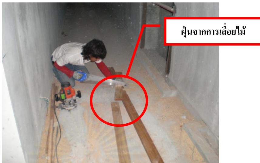
รูปที่ 4.1 การเลื่อยไม้ซึ่งทำให้เกิดฝุ่นละอองขณะเลื่อยและมีเศษไม้ตกลงเป็นที่มาของฝุ่นละออง
