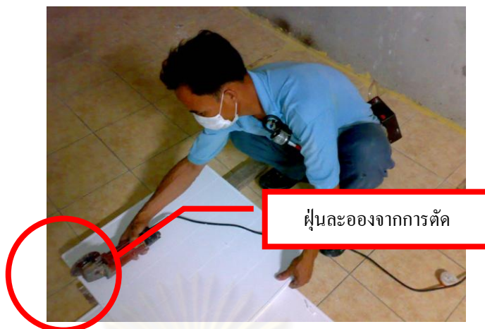
รูปที่ 5.31 การตัดแผ่นฝ้าด้วยเครื่องตัดไฟฟ้า
