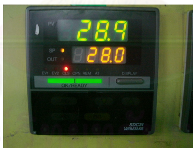
รูปที่ 5.1 การปรับตั้งค่าอุณหภูมิ
