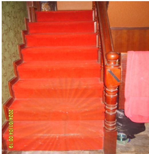
ภาพแสดงบันไดบ้านซึ่งมีการปูด้วยวัสดุกันลื่น
