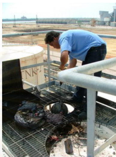
ภาพที่ 3.5 การเก็บตัวอย่างน้ำมันเตา
