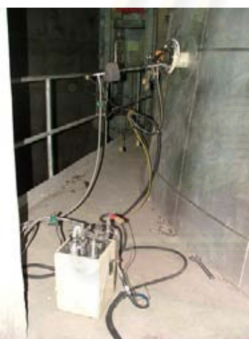
ภาพที่ 3.2 การติดตั้งอุปกรณ์ชักตัวอย่าง
