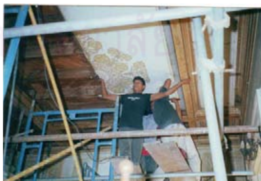
ภาพที่ 4-71 การติดตั้งแผ่นฝ้าและบัวฝ้าเพดานกลับตามรูปแบบเดิม : 2543
