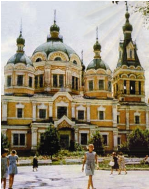
ภาพที่ 2-4 St. Ascension Cathedral ก่อนการบูรณะปี ค.ศ. 1994
