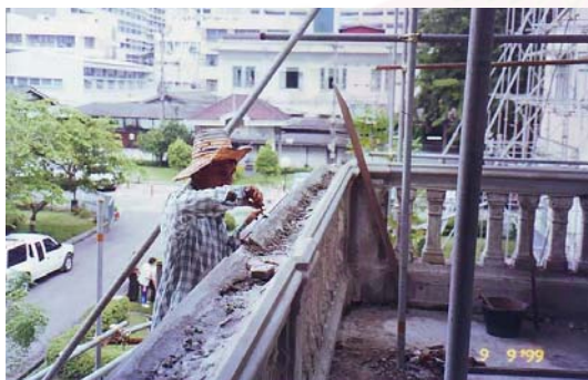
ภาพที่ 4-62 การซ่อมแซมราวลูกกรง : 2542 ที่มา : บริษัท เดียบอร์น สตรีท ดีไซน์ อินเตอร์เนชันแนล จำกัด
