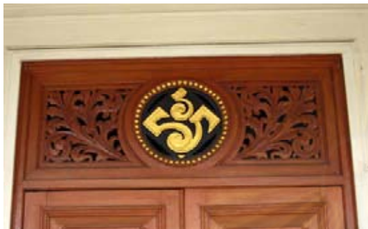
ภาพที่ 3-77 ช่องแสงลายฉลุไม้สักเหนือประตู ของพระที่นั่งฝ่ายหน้า : 2553 ที่มา : ผู้วิจัย
