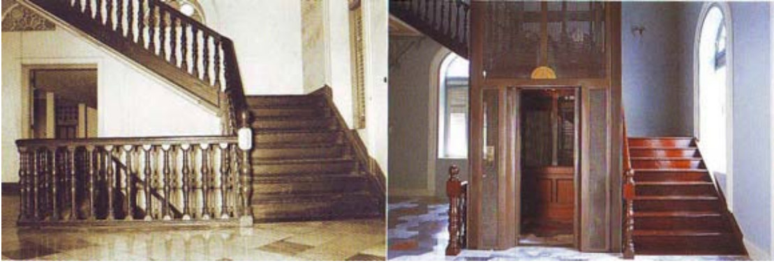
ภาพที่ 2-8 และภาพที่ 2-9 ภาพเปรียบเทียบโถงก่อนและหลังการเพิ่มลิฟต์โดยสารภายในอาคาร ที่มา : วัลลดาวัลย์, หน้า 68.
