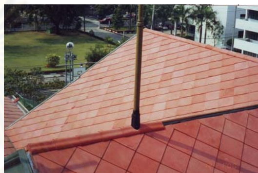
ภาพที่ 4-94 การติดตั้งสายนำไฟฟ้า
