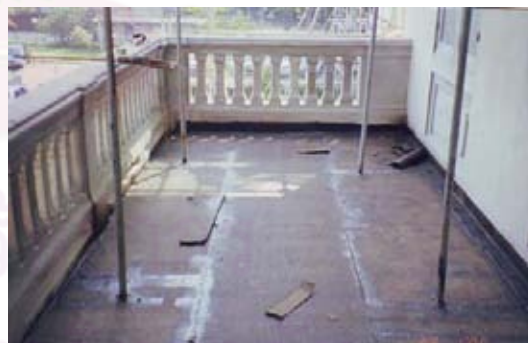
ภาพที่ 4-63 การทำระบบกันซึมก่อนปูพื้นหินอ่อน : 2542 ที่มา : บริษัท เดียบอร์น สตรีท ดีไซน์ อินเตอร์เนชันแนล จำกัด
