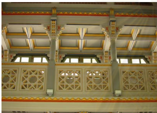
ภาพที่ 4-91 ท่อพัดลมเย็นวางบนระเบียงชั้น 2
