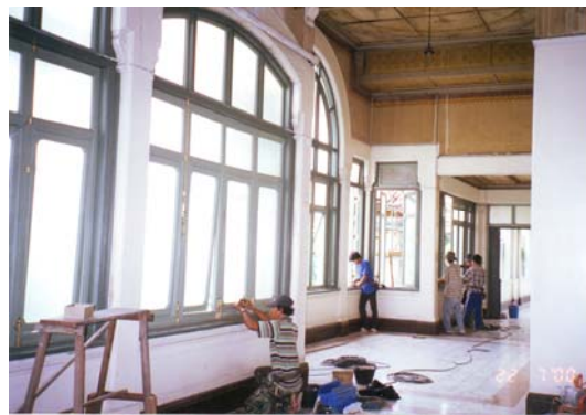
ภาพที่ 4-46 การติดตั้งอุปกรณ์ประตู หน้าต่าง : 2543 ที่มา : บริษัท เดียบอรัณ สตรีท ดีไซน์ อินเตอร์เนชันแนล จำกัด
