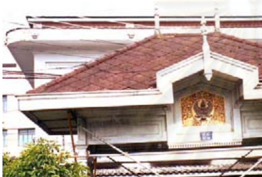
ภาพที่ 4-9 ศาลาครุฑ ก่อนการบูรณะ : 2542 ที่มา : บริษัท เดียบอร์น สตรีท ดีไซน์ อินเตอร์เนชั่นแนล จำกัด
