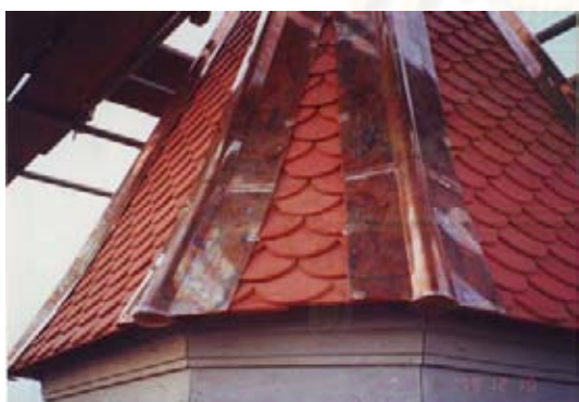
ภาพที่ 4-30 การติดตั้งแผ่นกันน้ำทองแดง ส่วนบนของ หลังคาหอคอย : 2552 ที่มา : บริษัท เดียบอร์น สตรีท ดีไซน์ อินเตอร์เนชั่นแนล จำกัด
