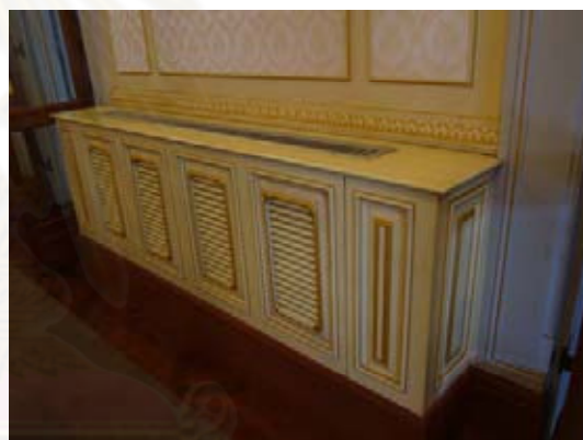
ภาพที่ 5-15 ตู้ครอบเครื่องพ่นลมเย็น ภายในห้องประชุม ที่มา : ผู้วิจัย
