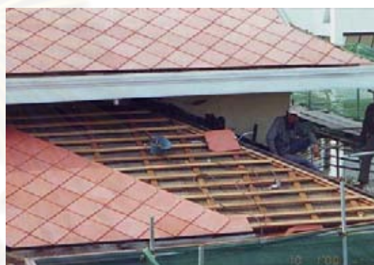
ภาพที่ 4-26 การติดตั้งกลอน ระแนงและกระเบื้อง : 2543
