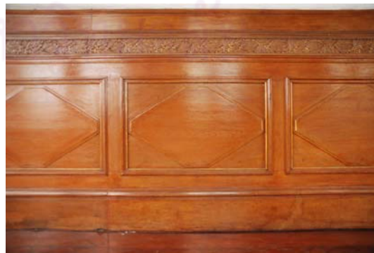
ภาพที่ 3-65 ผนังลูกฟักไม้ : 2549
