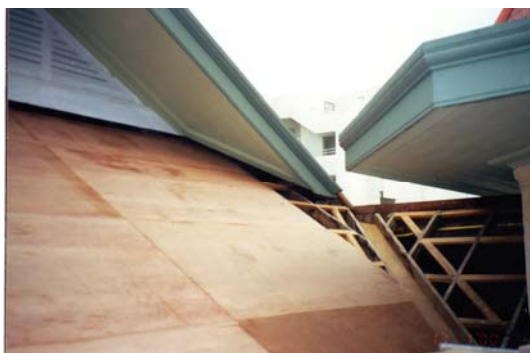
ภาพที่ 4-23 การปูแผ่นไม้อัดชนิดกันน้ำ : 2543
