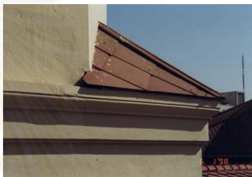
ภาพที่ 4-10 กระเบื้องแผ่นเรียบรูปเพชร มูมหอคอย พระที่นั่งศรีสุทธรินวาส : 2541 ที่มา : บริษัท เดียบอร์น สตรีท ดีไซน์ อินเตอร์เนชั่นแนล จำกัด
