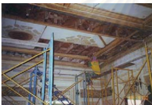
ภาพที่ 4-68 การรื้อถอดฝ้าเพดานและบัวฝ้าสำหรับซ่อมแซมโครงสร้างพื้นไม้ห้องท้องพระโรงชั้น 2 : 2543
