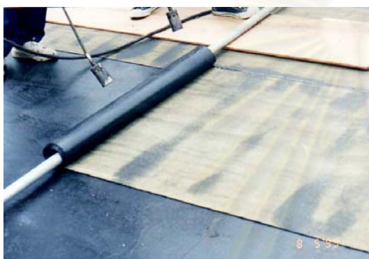
ภาพที่ 4-25 การปูแผ่นยางกันซึมด้วยการพ่นไฟ : 2543
