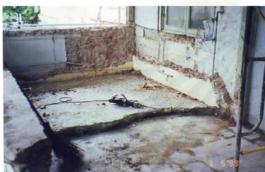
ภาพที่ 4-60 การสกัดพื้นกระเบื้องถึงหินอ่อนเดิม : 2542 ที่มา : บริษัท เดียบอร์น สตรีท ดีไซน์ อินเตอร์เนชันแนล จำกัด
