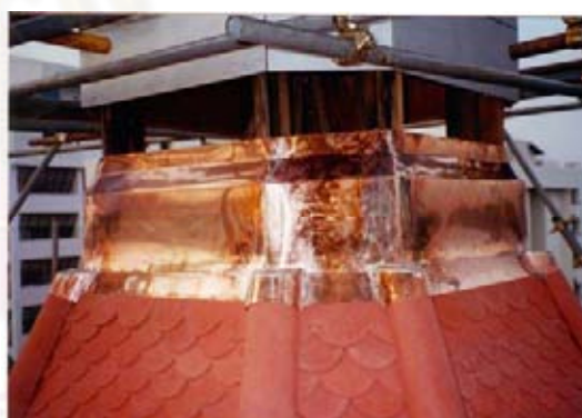
ภาพที่ 4-31 การติดตั้งแผ่นกันน้ำทองแดง ส่วนบนของ หลังคาหอคอย : 2552 ที่มา : บริษัท เดียบอร์น สตรีท ดีไซน์ อินเตอร์เนชั่นแนล จำกัด
