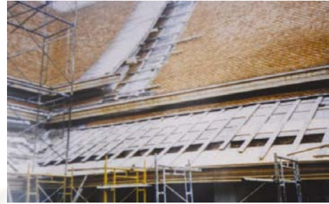
ภาพที่ 2-15 การบูรณะหลังคาท้องพระโรง
