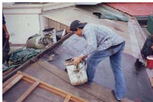
ภาพที่ 4-24 การทำน้ำยาของพื้นบนไม้อัด : 2543
