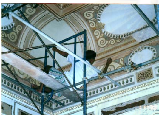
ภาพที่ 4-72 งานซ่อมแซมลายเขียนสี : 2543
