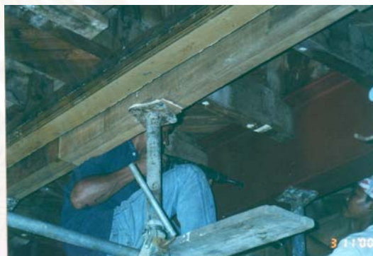
ภาพที่ 4-69 การติดตั้งคานเหล็กแทนคานไม้เดิมของโครงสร้างพื้นไม้ห้องท้องพระโรงชั้น 2 : 2543
