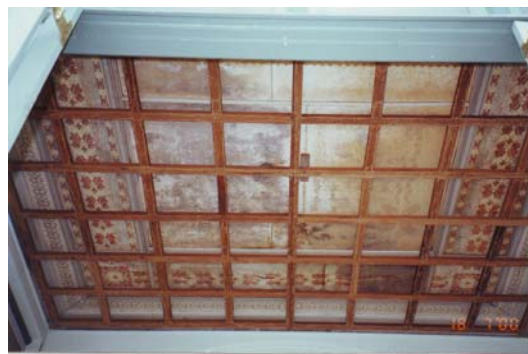
ภาพที่ 4-59 การรื้อฝ้าเพดานส่วนต่อเติม : 2542 ที่มา : บริษัท เดียบอร์น สตรีท ดีไซน์ อินเตอร์เนชันแนล จำกัด
