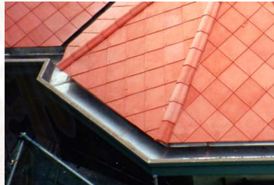
ภาพที่ 4-37 การขยายรางระบายน้ำฝน : 2542
