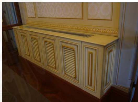
ภาพที่ 4-88 การติดตั้งเครื่องปรับอากาศในตู้ครอบเครื่อง
