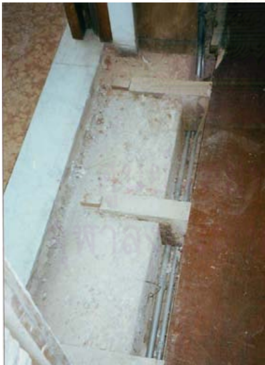
ภาพที่ 4-80 งานฝังท่อร้อยสายไฟใต้พื้น : 2549
