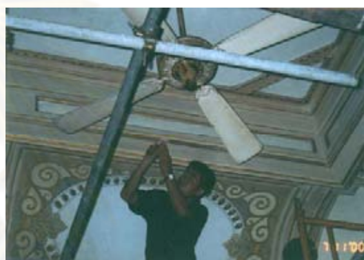
ภาพที่ 4-73 งานซ่อมแซมปิดทองบัวฝ้า : 2543
