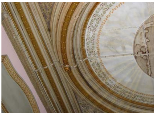
ภาพที่ 4-78 สายไฟเดินลอยบนฝ้าเพดาน : 2549
