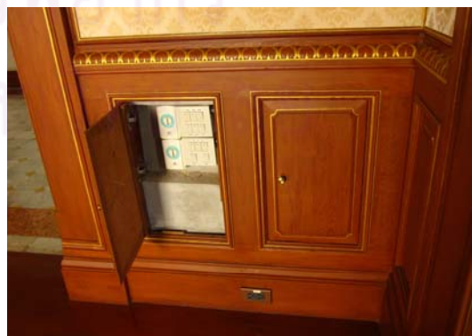
ภาพที่ 4-81 (บน)งานฝังท่อร้อยสายไฟในผนัง : 2549
