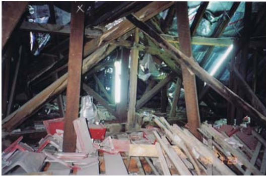
ภาพที่ 4-38 โครงสร้างหลังคา ก่อนการบูรณะ : 2541 ที่มา : บริษัท เดียบอร์น สตรีท ดีไซน์ อินเตอร์เนชั่นแนล จำกัด
