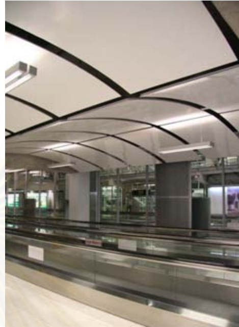
เปลี่ยนโคมไฟใหม่ หลอดฟลูออโรเรสเซนต์ T5 2x28 watt
