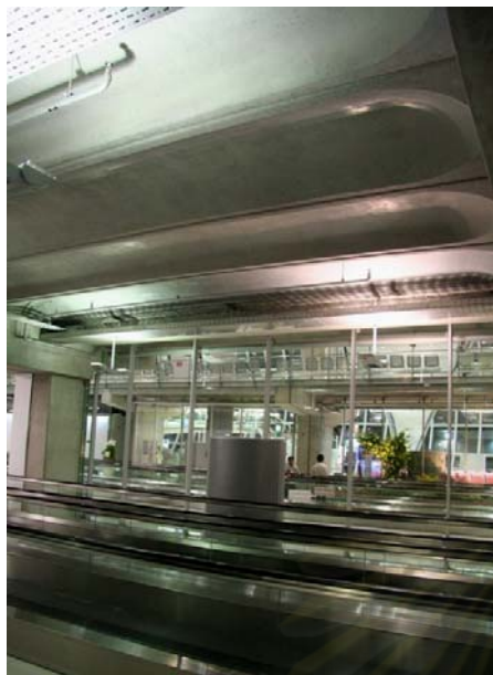
ภาพถ่ายก่อนปรับปรุง
