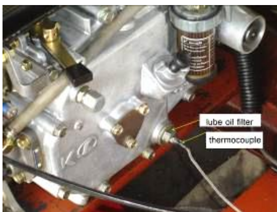
ภาพที่ 5-7 การติดตั้งตำแหน่งของเทอร์โมคัปเปิลที่ตัวกรองน้ำมันหล่อลื่น
