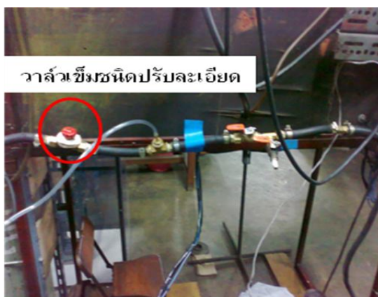
ภาพที่ 5-20 การติดตั้งระบบควบคุมปริมาณก๊าซโดยใช้วาล์วเข็มชนิดปรับละเอียด
