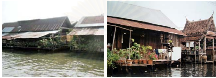
ภาพที่ 5.2 แสดงอาคารที่มีลักษณะแบบหลังคาจั่วยกสูงมีชายคาบริเวณวัดคูหาสวรรค์ (ซ้าย) และบริเวณชุมชนบางแวก (ขวา) ที่มา : จากการสำรวจ,2547.
