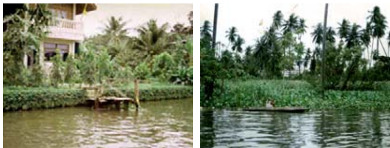
ภาพที่ 5.12 แสดงเขื่อนกันตลิ่งที่ใช้วัสดุธรรมชาติ(ซ้าย) และพื้นที่ป้องกันน้ำเซาะตลิ่ง(ขวา) ที่มา : จากการสำรวจ,2547.
