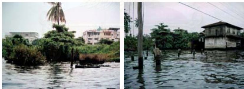
ภาพที่ 5.16 แสดงลักษณะพื้นที่ที่ถูกน้ำเซาะตลิ่งพัง(ซ้าย) และพื้นที่อาคารที่น้ำท่วมจนพัง(ขวา)
