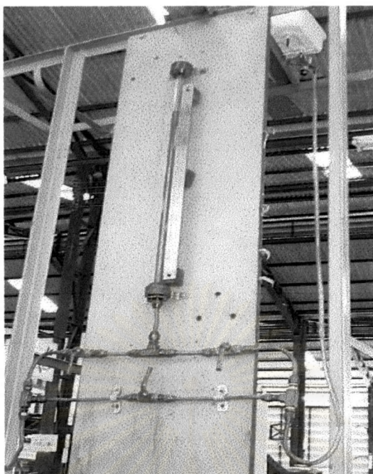
รูปที่ 5.15 การติดตั้งถังน้ำมันเชื้อเพลิงเข้ากับชุดวัดอัตราการไหลของน้ำมันเชื้อเพลิง
