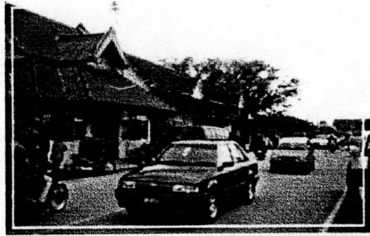
อาคารที่ทำการบริเวณด้านมีสภาพเก่าแก่ทรุดโทรม
