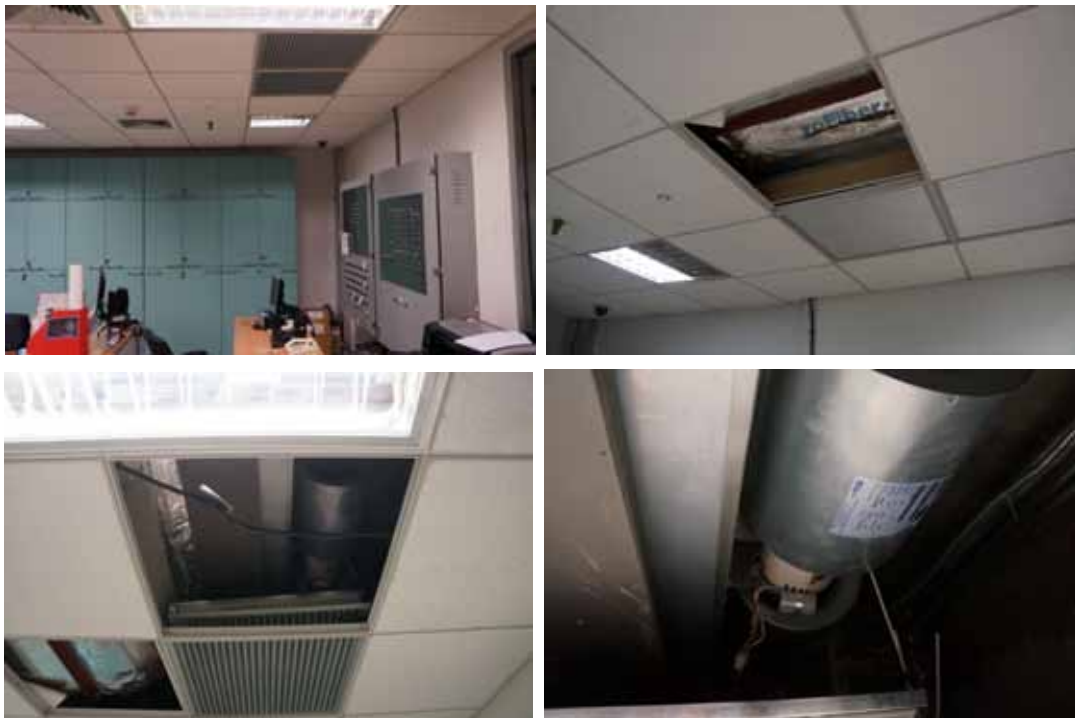
ภาพที่ 4-46 แสดงภาพเมื่อปรับปรุงแล้วเสร็จ โครงการที่ 20
