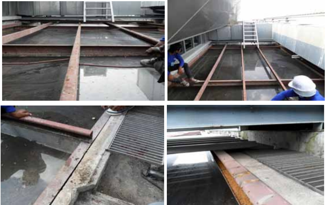
ภาพที่ 4-42 แสดงภาพขณะปรับปรุง โครงการที่ 18
