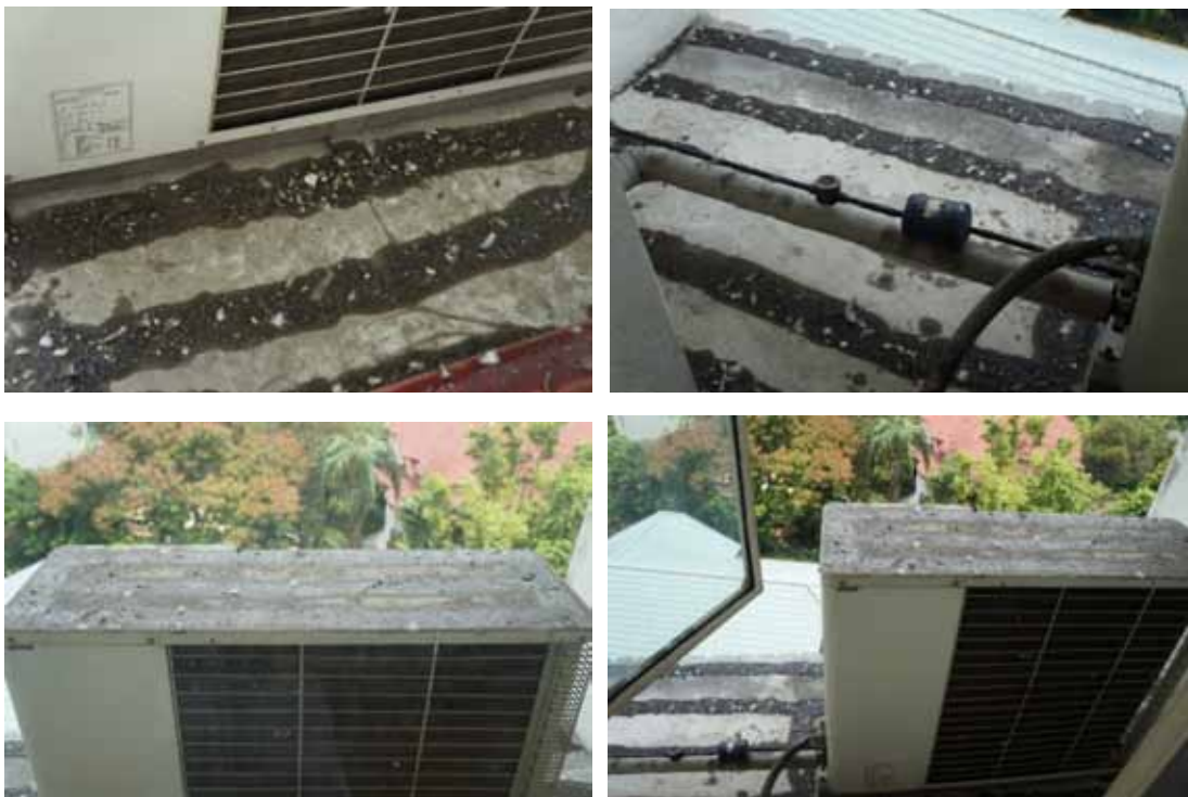
ภาพที่ 4-7 แสดงภาพเมื่อปรับปรุงแล้วเสร็จ โครงการที่ 2
