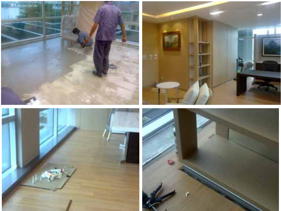
ภาพที่ 4-70 แสดงภาพขณะปรับปรุง โครงการที่ 35
