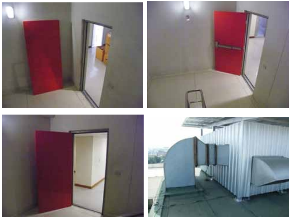
ภาพ 4-63 แสดงภาพเมื่อปรับปรุงแล้วเสร็จ โครงการที่ 29
