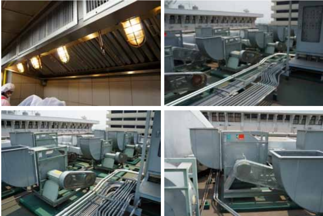
ภาพที่ 4-74 แสดงภาพเมื่อปรับปรุงแล้วเสร็จ โครงการที่ 37
