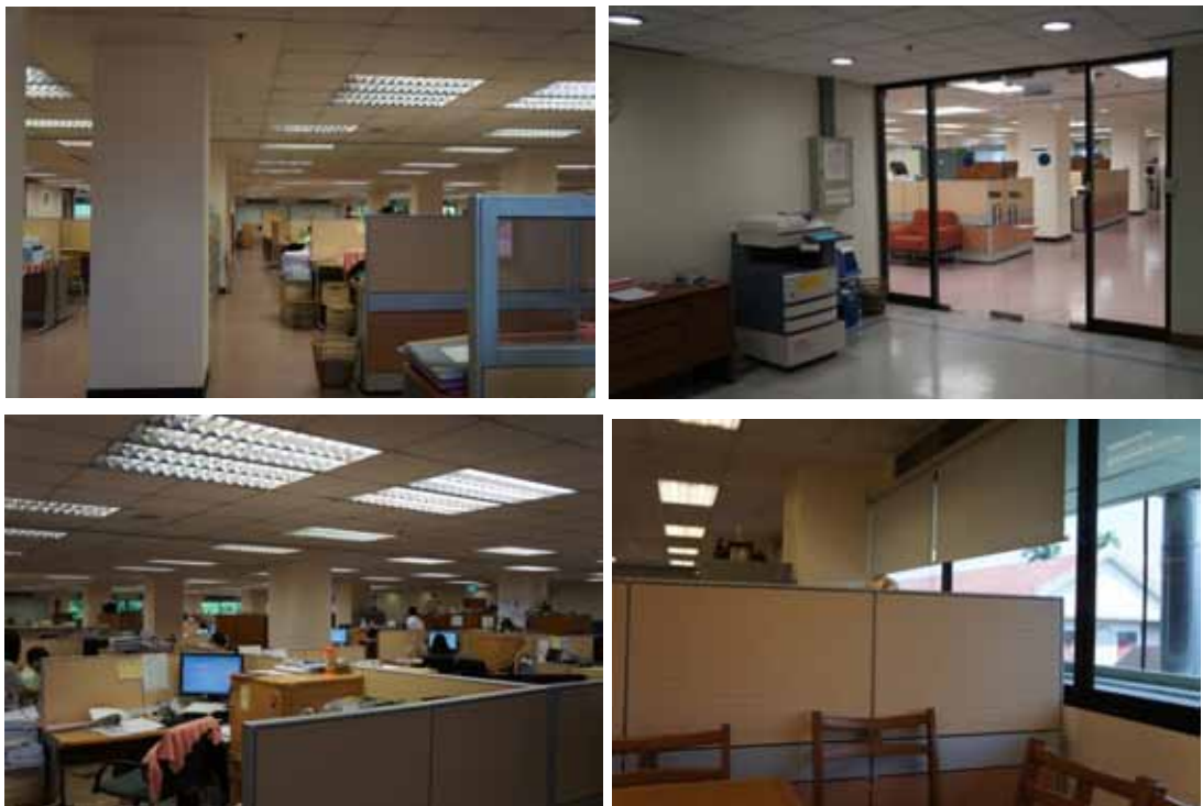
ภาพที่ 4-52 แสดงภาพเมื่อปรับปรุงแล้วเสร็จ โครงการที่ 23
