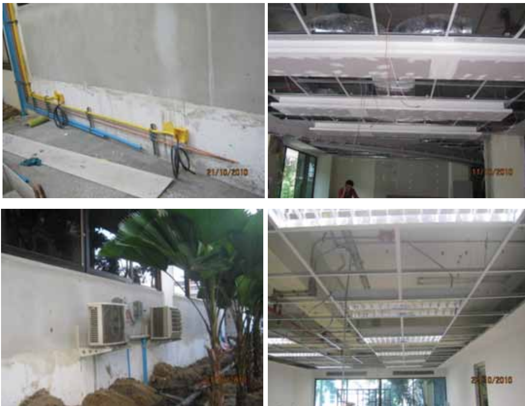
ภาพที่ 4-10 แสดงภาพขณะปรับปรุง โครงการที่ 3
