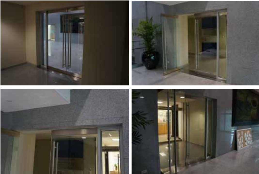
ภาพที่ 4-64 แสดงภาพเมื่อปรับปรุงแล้วเสร็จ โครงการที่ 30
