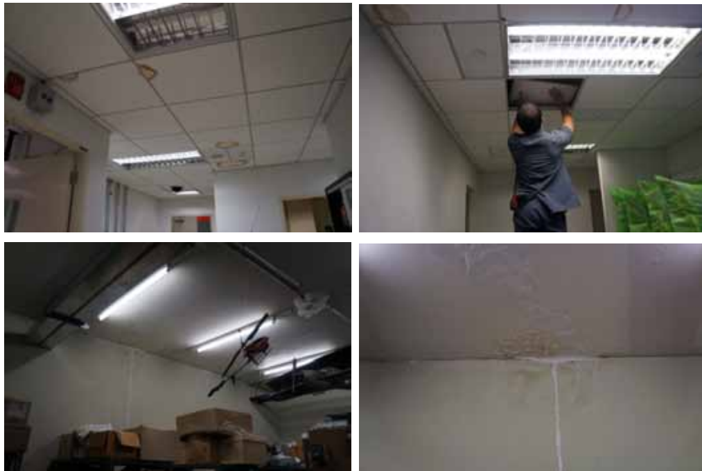
ภาพที่ 4-76 แสดงภาพเมื่อปรับปรุงแล้วเสร็จ โครงการที่ 39
