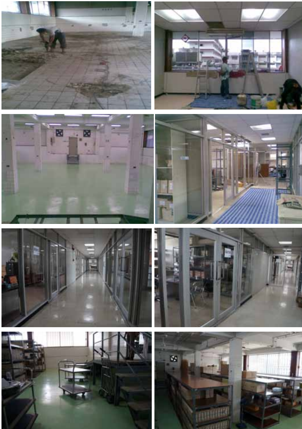
ภาพที่ 4-73 แสดงภาพขณะปรับปรุงแล้วเสร็จ โครงการที่ 36
