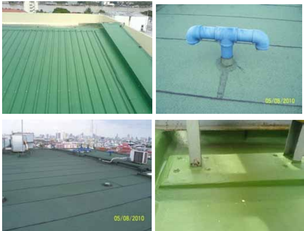
ภาพที่ 4-18 แสดงภาพเมื่อปรับปรุงแล้วเสร็จ โครงการที่ 7
