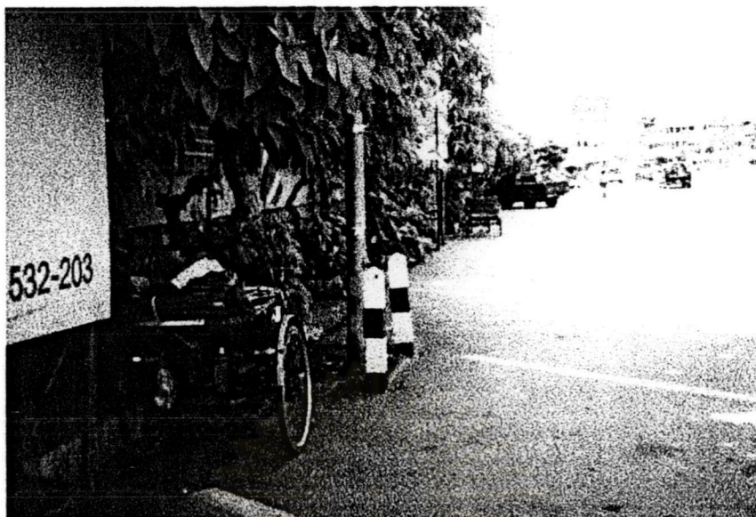
ภาพก่อนการปรับปรุงระบบทางเดินเท้า (ความไม่ต่อเนื่องของทางเดินเท้า)
