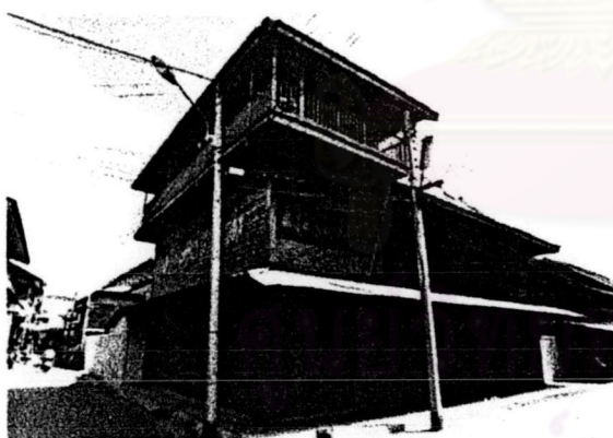
3 อาคารไม้สูง 3 ชั้นหลังแรกและหลังเดียวของหัวหิน
