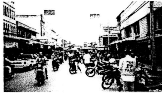
1 อาคารพาณิชย์บริเวณหลังตลาดจตุรไชย เป็นอาคารคอนกรีต สูง 2-4 ชั้น
