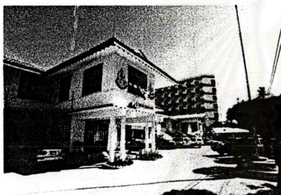
1 อาคารราชการที่เป็นอาคารคอนกรีตสูง 2 ชั้น และโรงแรมซิตีบีชที่ตั้งถัดไปเป็นอาคารคอนกรีตสูง 6 ชั้น
