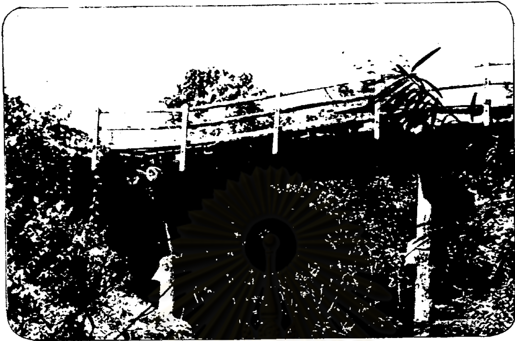
รูป 4-8 ตอม่อสะพานไม้ในเขตอำเภopakขม จ.เลย ถูกกระแสน้ำกัดเซาะจนไม่สามารถรับน้ำหนักได้ และทรุดตัวลงในที่สุด
