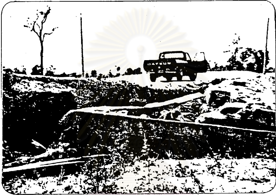
รูป 4-18 สภาพทางน้ำผ่านถนน (Wet Crossing) ที่ถูกกัดเซาะด้าน ท้ายน้ำ
