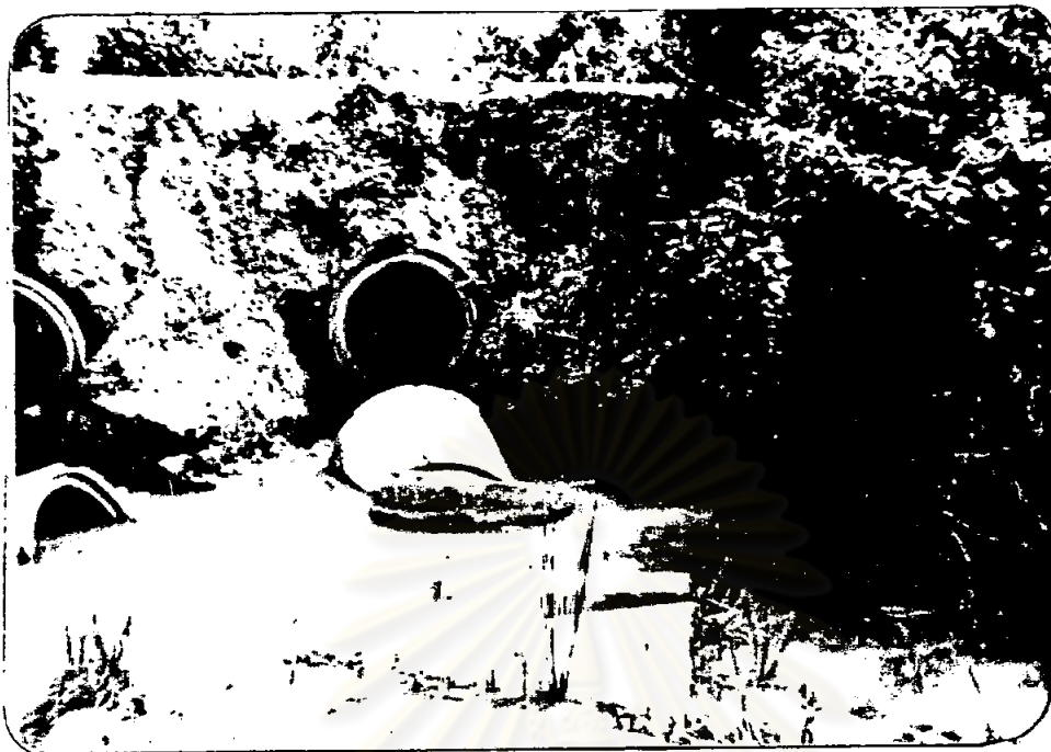
รูป 4-16 ท่อขนาด \phi 0.80 เมตร ถูกกีดขวางเสียหายใช้การไม่ได้
