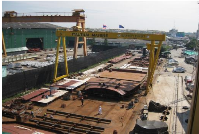
ภาพที่ 2.5 Gantry Crane ขนาด 16 ตัน
