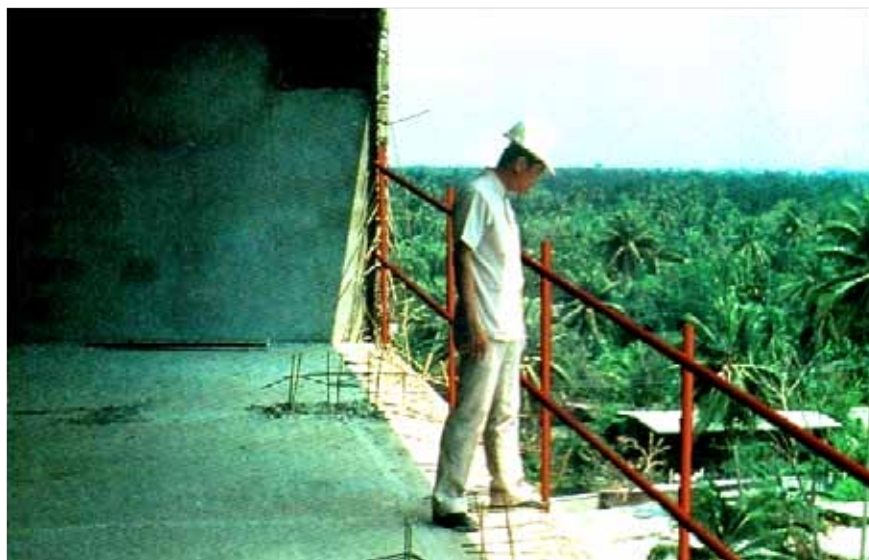
ภาพที่ 4.11 ภาพราวกันตกจำลองแบบที่ 2 เทียบกับขนาดตัวของคนงาน
