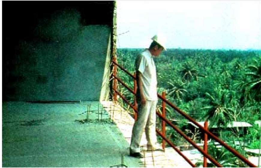
ภาพที่ 4.12 ภาพราวกันตกจำลองแบบที่ 3 เทียบกับขนาดตัวของคนงาน
