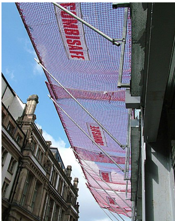
ภาพที่ ข.2 ระบบตาข่ายนิรภัย (Safety Net Systems)
