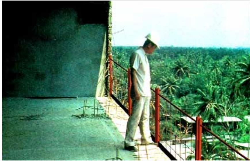
ภาพที่ 4.14 ภาพราวกันตกจำลองแบบที่ 5 เทียบกับขนาดตัวของคนงาน
