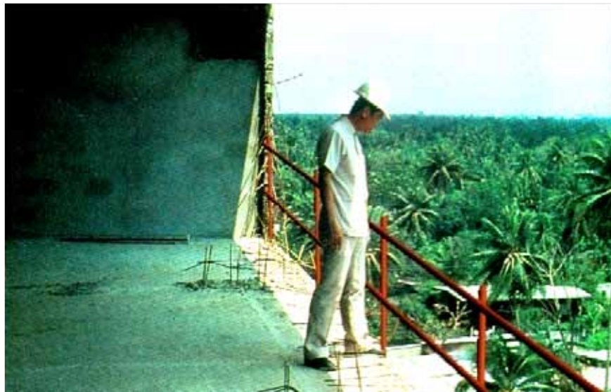
ภาพที่ 4.10 ภาพราวกันตกจำลองแบบที่ 1 เทียบกับขนาดตัวของคนงาน
