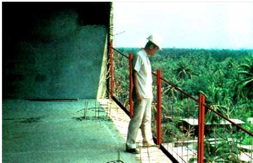
ภาพที่ 4.15 ภาพราวกันตกจำลองแบบที่ 6 เทียบกับขนาดตัวของคนงาน
