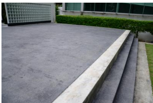
รูปที่ 20 มุมมองที่เป็น พื้นที่คอนกรีตยกระดับมีขั้นบันได และมองเห็นส่วนของอาคาร
