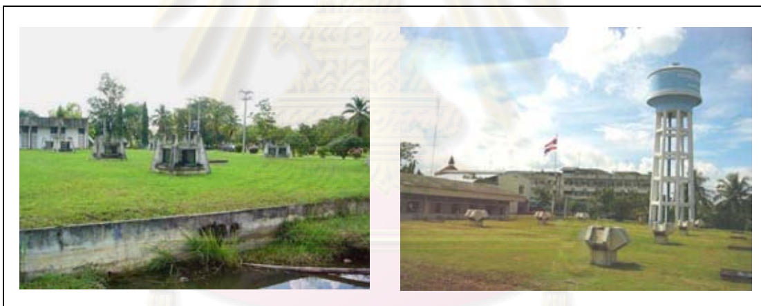
รูปที่ 4.19 ถังเก็บน้ำใสใต้ดินและหอถังสูงของเทศบาลนครนครปฐม
