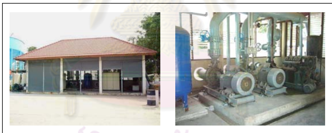
รูปที่ 4.14 อาคารสูบน้ำแรงสูงและเครื่องสูบน้ำแรงสูงของเทศบาลนครพระนครศรีอยุธยา
