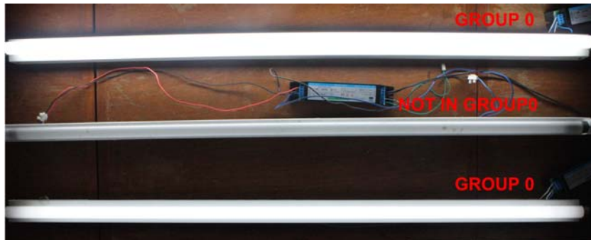
ภาพที่ 5-14 การควบคุมระดับการส่องสว่างแบบกลุ่ม
