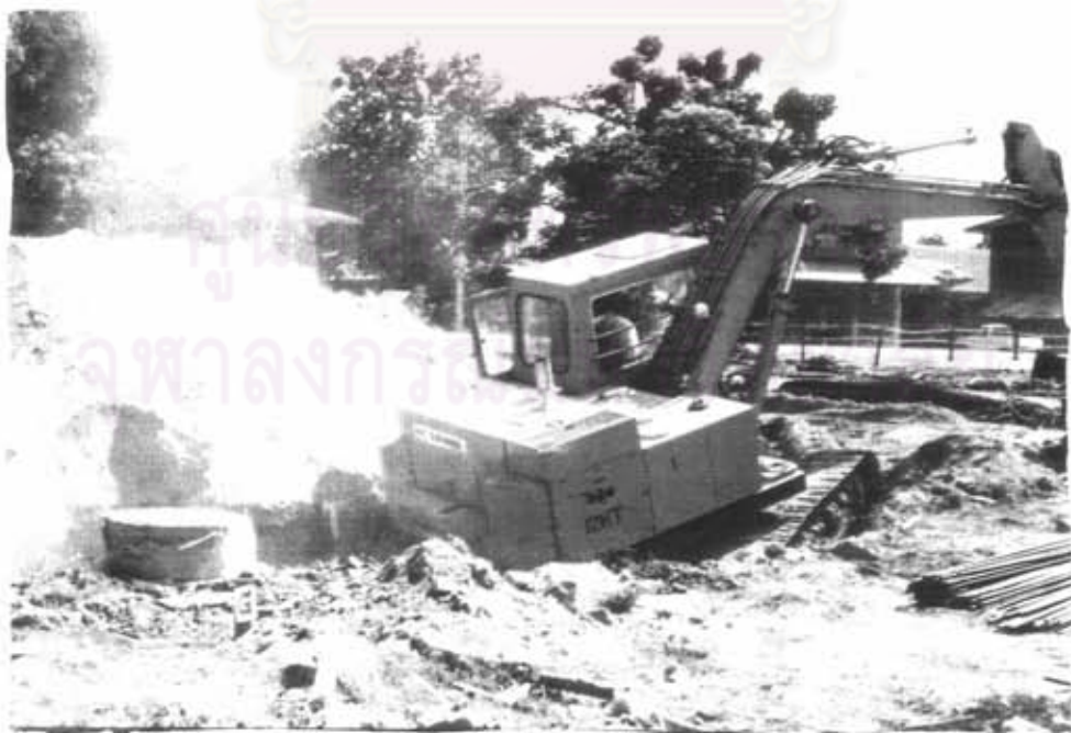
ภาพที่ 6 ขณะทำการเปิดหน้าดินเพื่อทำการขุดเสาเข็มขึ้นมา
