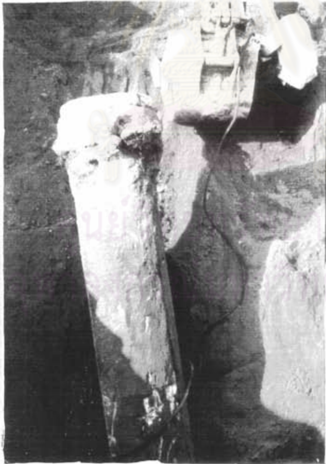
ภาพที่ 8 ขณะทำการผูกเสาเข็มด้วยสลิง เพื่อเตรียมลากขึ้นจากหลุม
