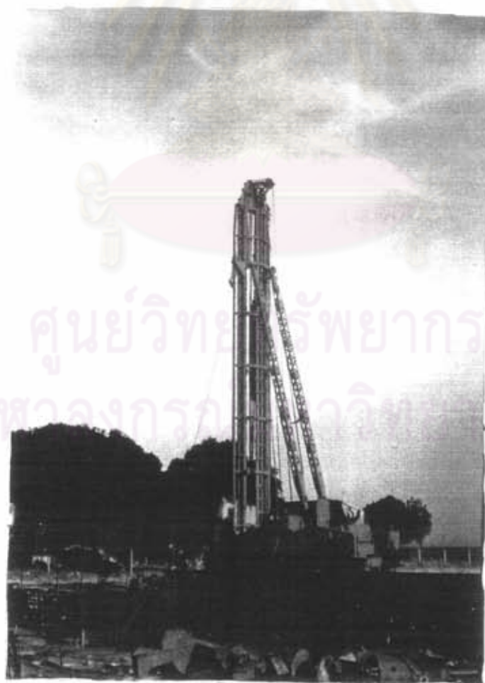
ภาพที่ 2 ปั่นจั่น " Franki " สำหรับตอกเสาเข็ม Franki
