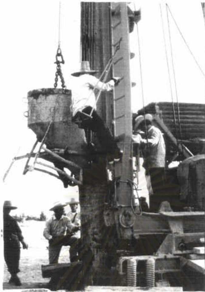
ภาพที่ 3 ขณะทำการเท " คอนกรีตแห้ง " (dry mixed concrete) เพื่อทำการตอกขยายฐาน (expanded base)
