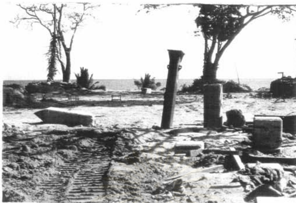
ภาพที่ 1 ลักษณะของเข็มตอกที่ใช้กันโดยทั่วไป มักมีปัญหาคือ การตอกไม่ถึงความลึกที่ได้ออกแบบและเสาเข็มหัก
