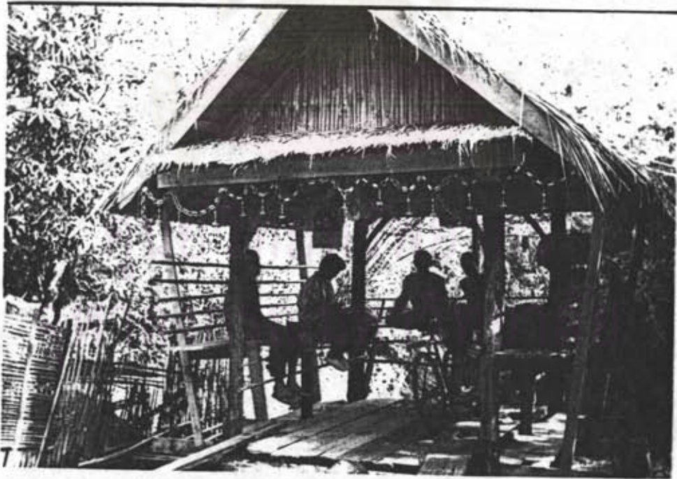
ภาพที่ 23 คู่มุประจําหมู่บ้าน หลังคามุงแฝก
