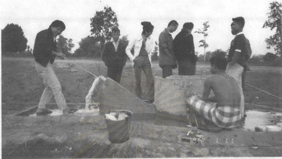
(ค) เครื่องสูบน้ำใช้มือ ติดตั้งโดยกลุ่มเทคโนโลยีเหมาะสม คณะวิศวกรรมศาสตร์ จุฬาลงกรณ์มหาวิทยาลัย ที่บ้านป่ากล้วย
