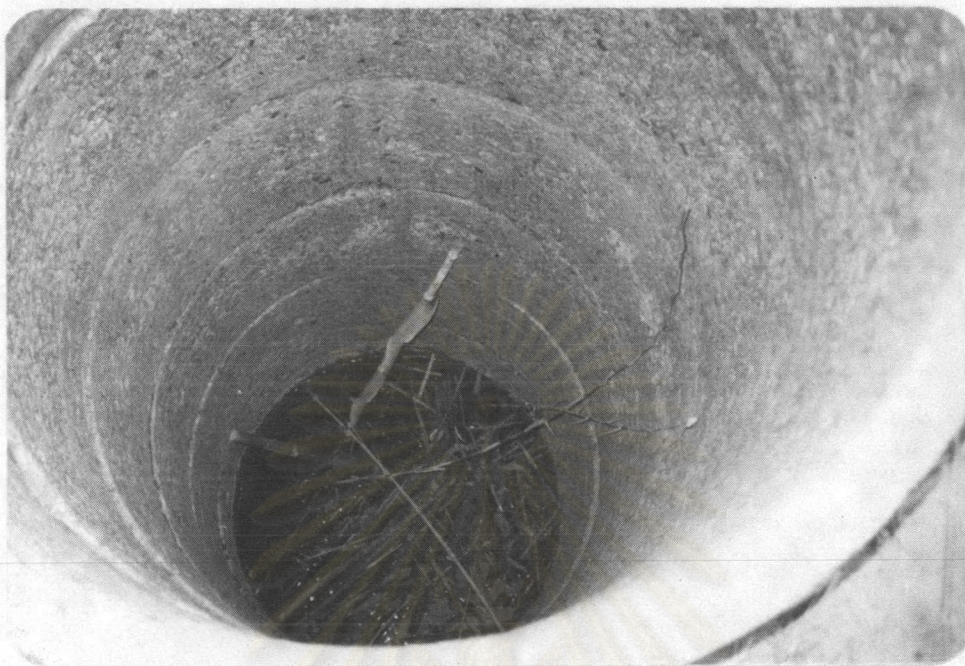
(ค) สภาพบ่อปลอกคอนกรีต บ้านดงน้อย
