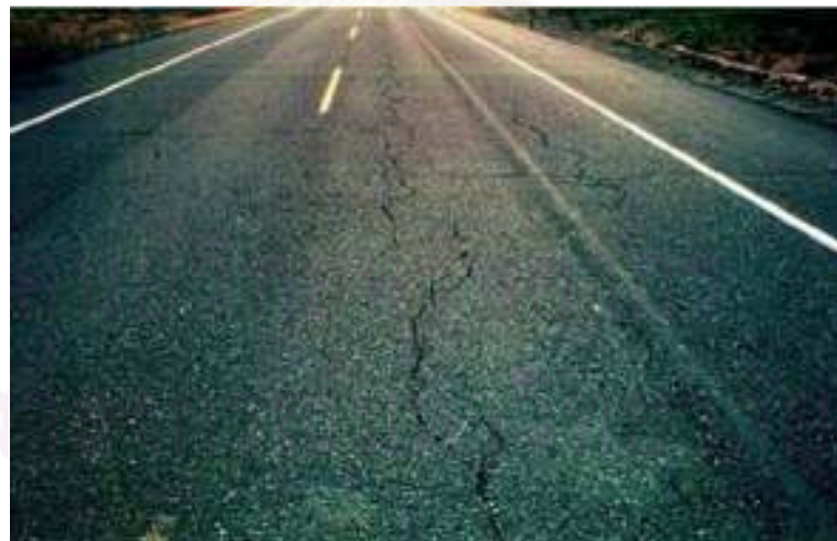
รูปที่ 2.4 รอยแตกร้าวตามแนวยาว (Longitudinal cracking) (เอกสารประกอบรายวิชา Pavement Design)
