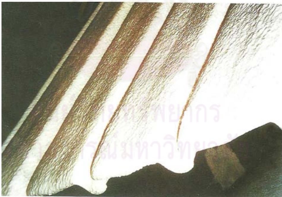
ภาพที่ 2.21 ตัวอย่างโฟมโพลีเอทิลีนแบบฟองที่ใช้กับหลังคา สามารถติดตั้งได้กับพื้นผิวทุกลักษณะและติดแน่นกับพื้นผิว วิธีการติดตั้งทำได้ง่ายและไม่มีรอยต่อ สามารถเพิ่มค่าความต้านทานความร้อนทำได้โดยการเพิ่มความหนาของโฟม (สุนทร บุญญาธิการ, 2543)
