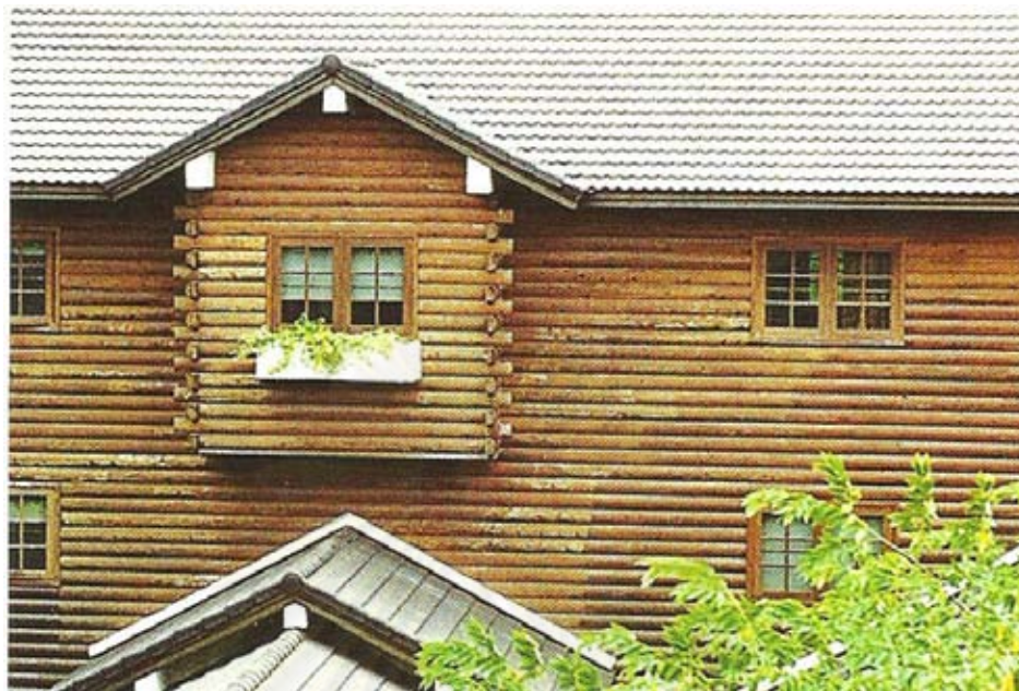
ภาพที่ 2.3 ลักษณะของการใช้ผนังไม้เป็นผนังภายนอกอาคาร ซึ่งมีความสวยงามและกลมกลืนกับสภาพแวดล้อม ไม้เป็นวัสดุที่มีความเป็นฉนวนกันความร้อนได้ในระดับหนึ่ง แต่มีค่าการดูดซับความชื้นค่อนข้างสูง (สุนทร บุญญาธิการ, 2543)
