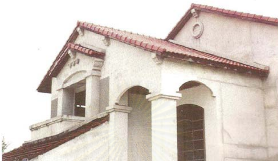
ภาพที่ 2.2 ลักษณะของผนังก่ออิฐฉาบปูน ซึ่งเป็นผนังที่นิยมใช้ในปัจจุบัน มีความแข็งแรงทนทาน และมีมวลสารมาก (สุนทร บุญญาธิการ, 2543)
