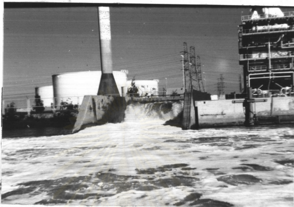
4.3 สถานที่ 3 (หน้าทางระบายน้ำออก จากโรงไฟฟ้า พลังความร้อนร่วม)
