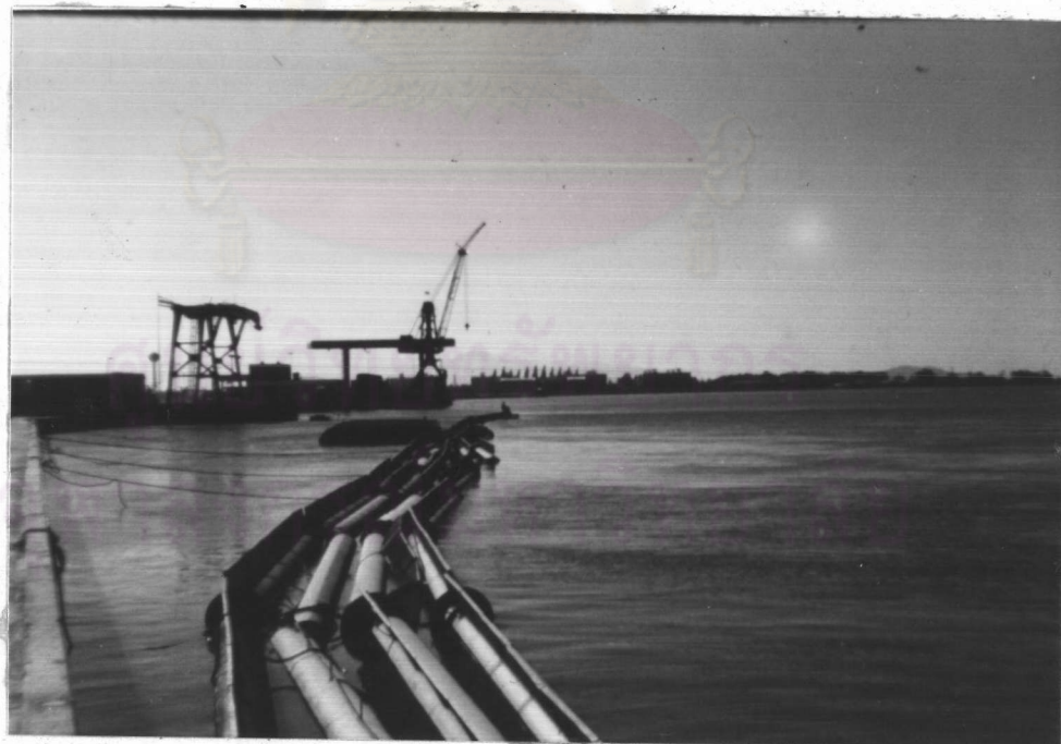
4.4 สถานที่ 4 (หน้าทางน้ำเข้าโรงไฟฟ้า)
